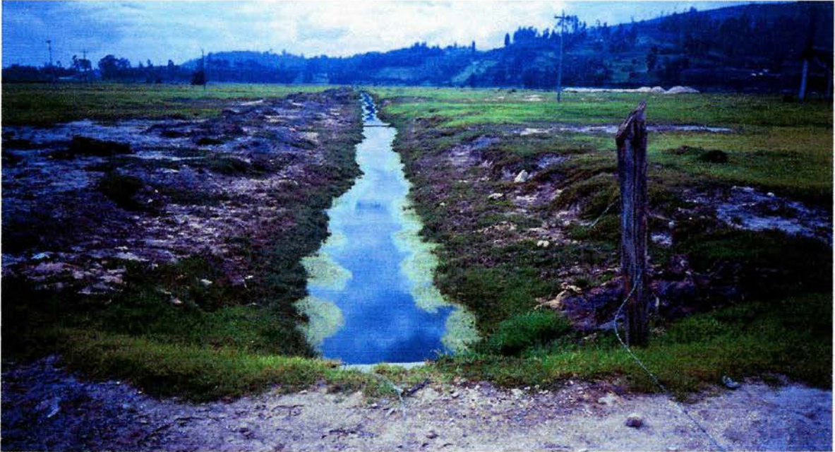
Figura 17. Canal en tierra por donde circula agua residual termal combinada con agua residual doméstica proveniente del sector hotelero.
