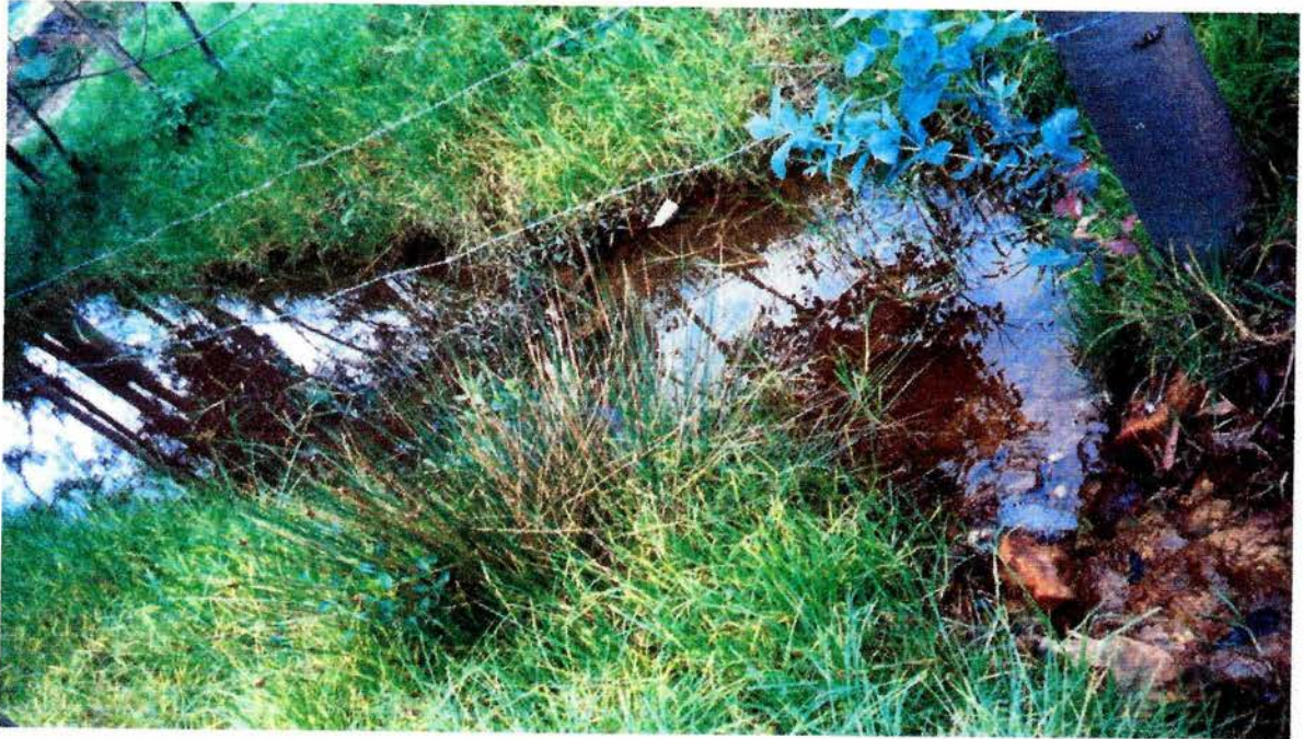
Figura 30. Tratamiento con humedales para las aguas ácidas provenientes de las minas sector Salitre 2.
