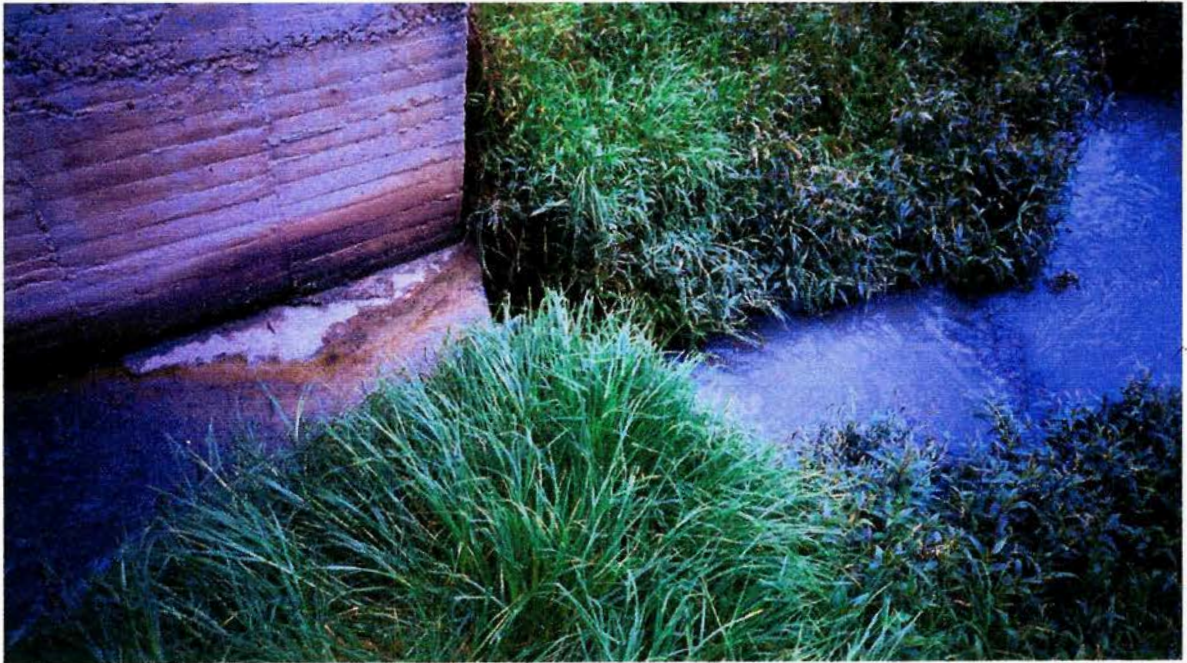
Figura 15. Descarga del efluente proveniente del alcantarillado perimetral del sector hotelero al río Chicamocho.
