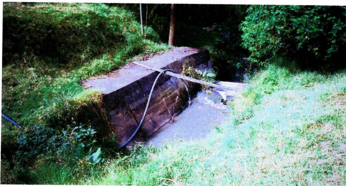
Figura 14. Captación de aguas servidas para el riego de cultivos.
