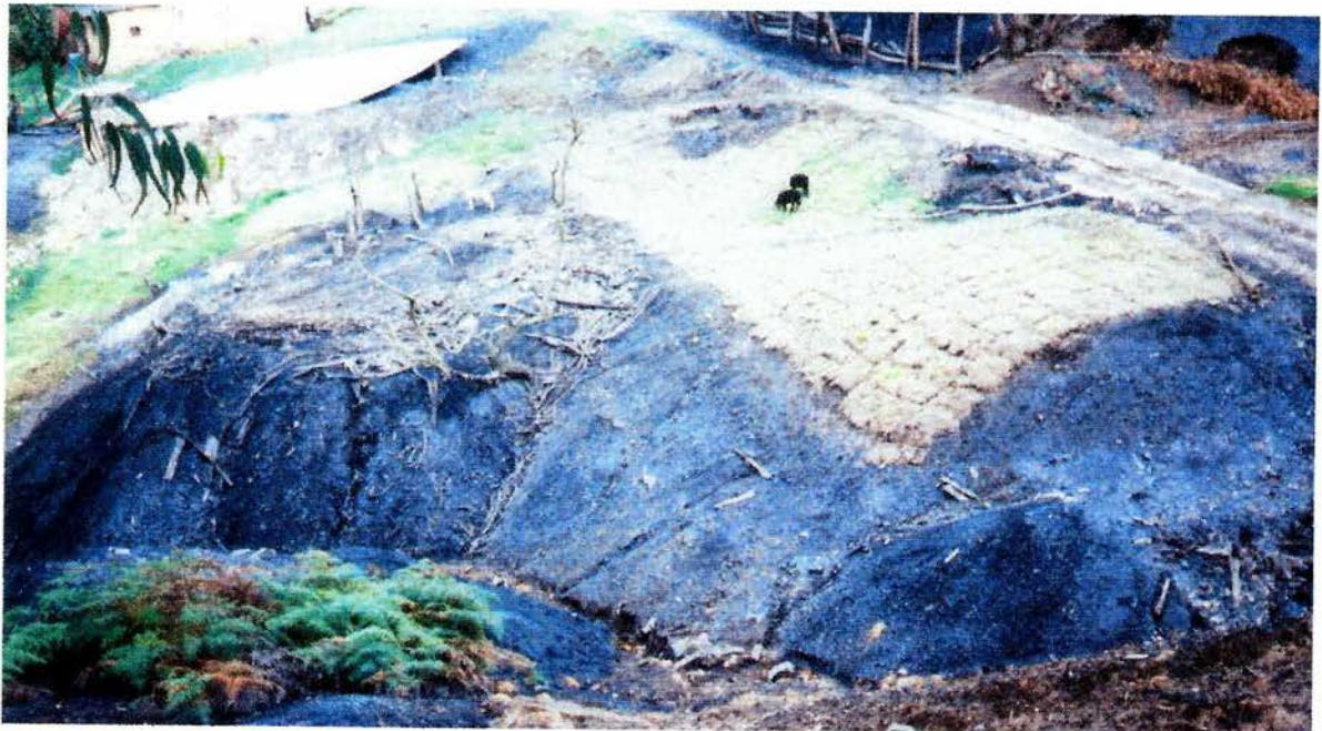
Figura 28. Recuperación de la zona de disposición de estériles mediante la siembra de cespedón.
