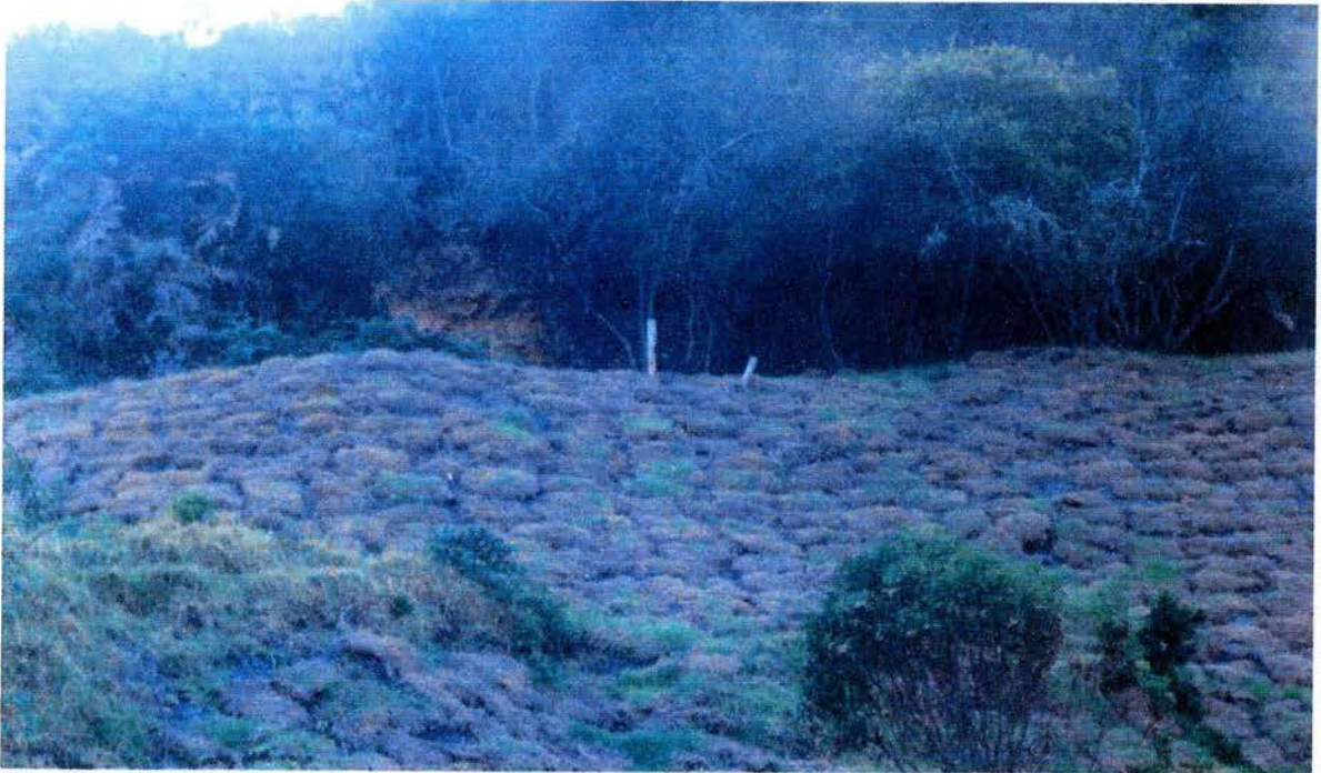
Figura 32. Recuperación de la zona de disposición de estériles provenientes de la minería de carbón mediante la siembra de cespedón sector El Volcán.
