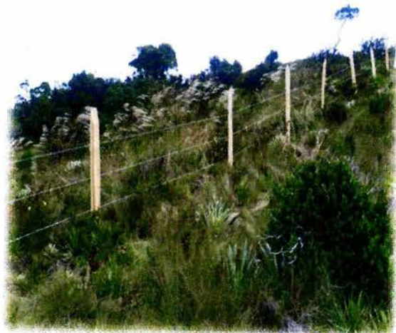
Trazo, ahoyado e instalación de cercado para aislamiento de predios
