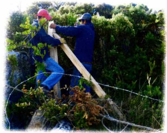
Trazo, ahoyado e instalación de cercado para aislamiento de predios
