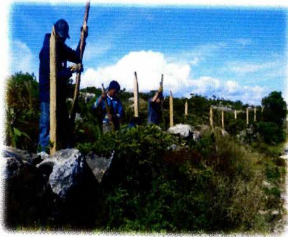
Trazo, ahoyado e instalación de cercado para aislamiento de predios
