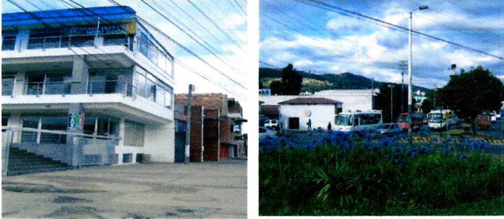
Figura 5. Recorrido Inspección inicial Tunja
