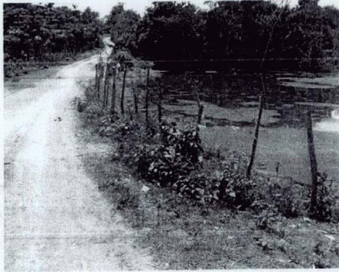
Lago que desborda hacia la carretera
