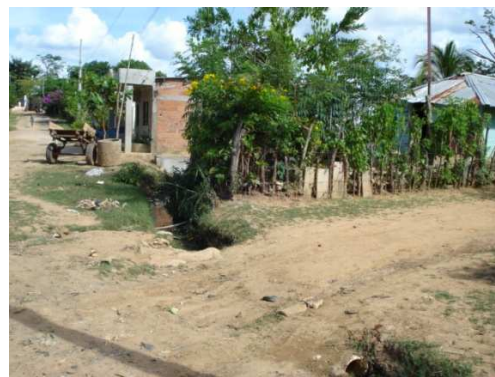
Foto. Canal que evacua el agua de escorrentía y agua residual. Barrio Palma Soriana. Tubería de Poca sección
