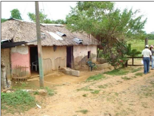
Foto Sitio afectado por inundación, Casa de Damaris Parra, barrio San Gabriel.
