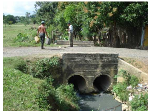
Foto. Sitio de inundación Barrio Centenario. Estructura de paso, alcantarilla con doble tubo en concreto d = 1 m Aguas arriba.
