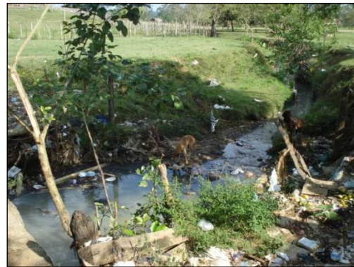
Foto. Cambio de sección del canal. Viviendas amenazadas por inundación. Vista aguas abajo, Barrio Bolívar
