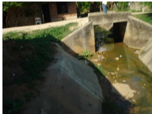
Foto. Arroyo el Desorden. Estructura de paso tipo Box
