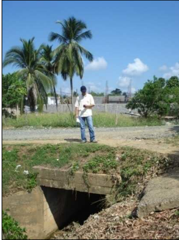
Foto. Estructura de paso. Alcantarilla tipo Box, Sitio donde se recoge el agua que nace en la parte trasera de Rápido Ochoa, en dirección hacia el barrio Centenario.
