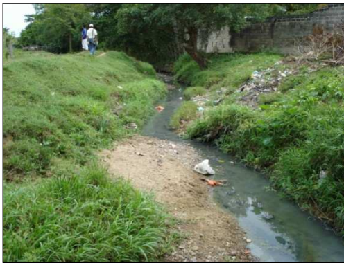
Foto. Sitio de depositación de arenas arrastradas producto de la erosión que se presenta en el canal.
