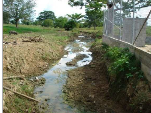
Foto. Sección del canal, aguas abajo fuera del perímetro urbano, al lado de la estación de bombeo
