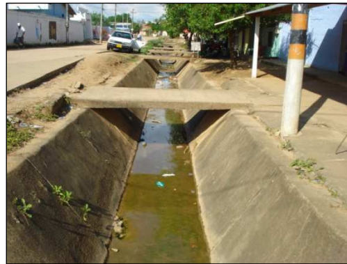
Foto. Arroyo el desorden Sección trapezoidal revestida en concreto. Carrera 16 con Calle 20.
