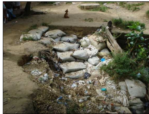
Foto. Bolsasuelo, dispuestos en el sitio, para mitigar la erosión.
