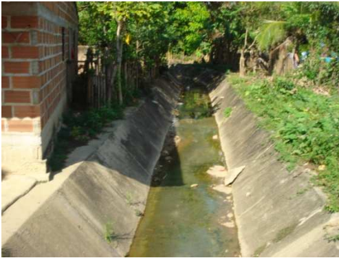
Foto. Arroyo el Desorden Sección trapezoidal revestida en concreto.
