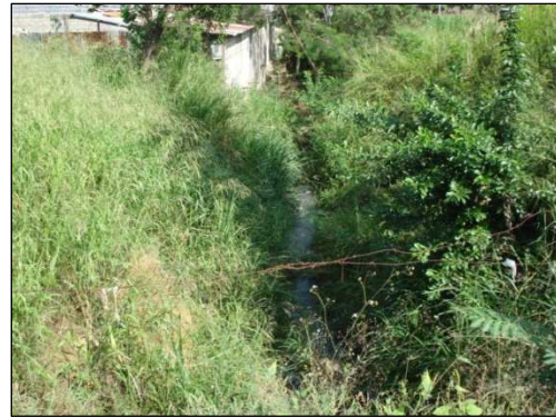
Foto. Canal en tierra. Transporta aguas residuales y aguas lluvias en dirección hacia el Barrio Centenario, a descargar al arroyo Carolina.
