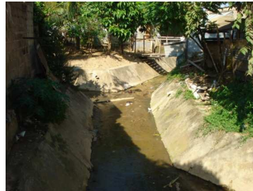
Foto. Arroyo el Desorden Sección trapezoidal revestida en concreto
