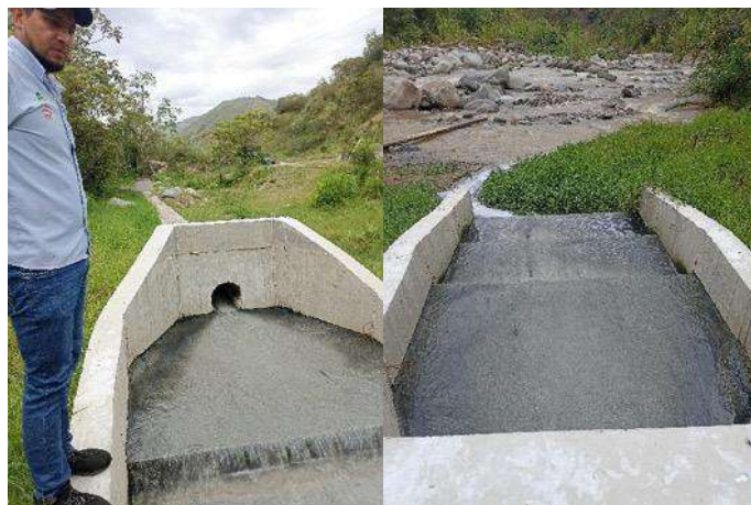
PTAR Santa María, con la prolongación de la tubería y construcción de una nueva estructura de descarga final al Río Baché, se mitigaron olores.
