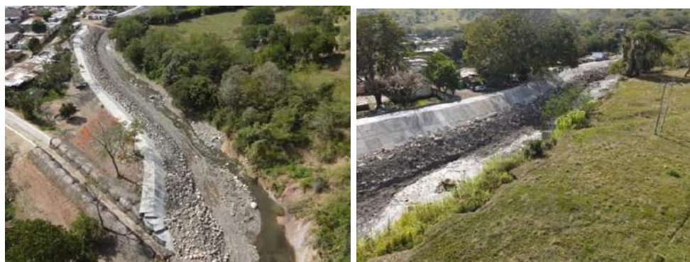
Municipio de Timaná, obra de canalización del río Timaná
