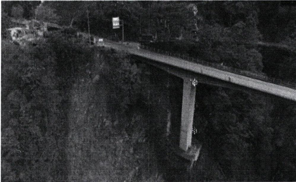
*Este puente no cuenta con cimentación profunda, por lo que la zapata estaría expuesta si continua la degradación y concluiría, sin intervención, en un posible colapso de la estructura. (...)*
