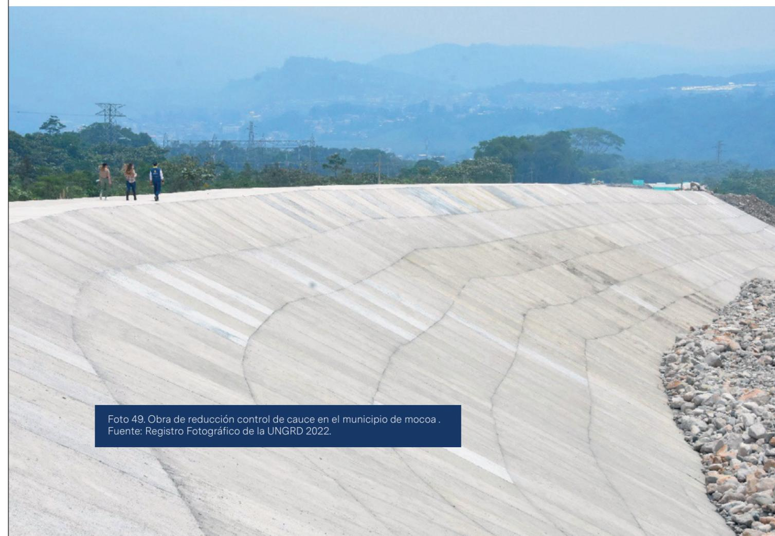
Foto 49. Obra de reducción control de cauce en el municipio de Mocoa. Fuente: Registro Fotográfico de la UNGRD 2022.
