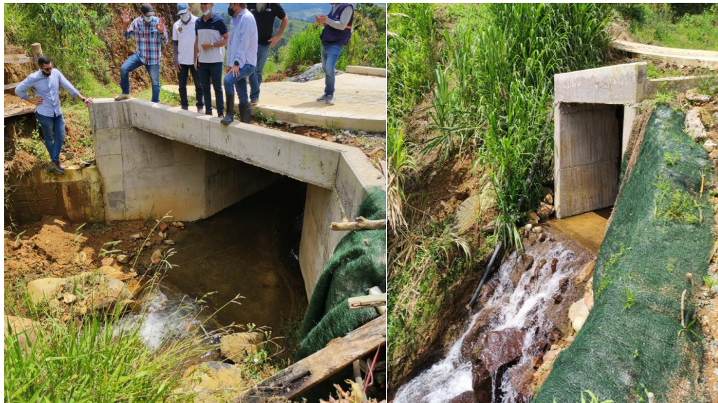
Figura 248. Obra de cruce existente sobre la quebrada Valladares – P2
