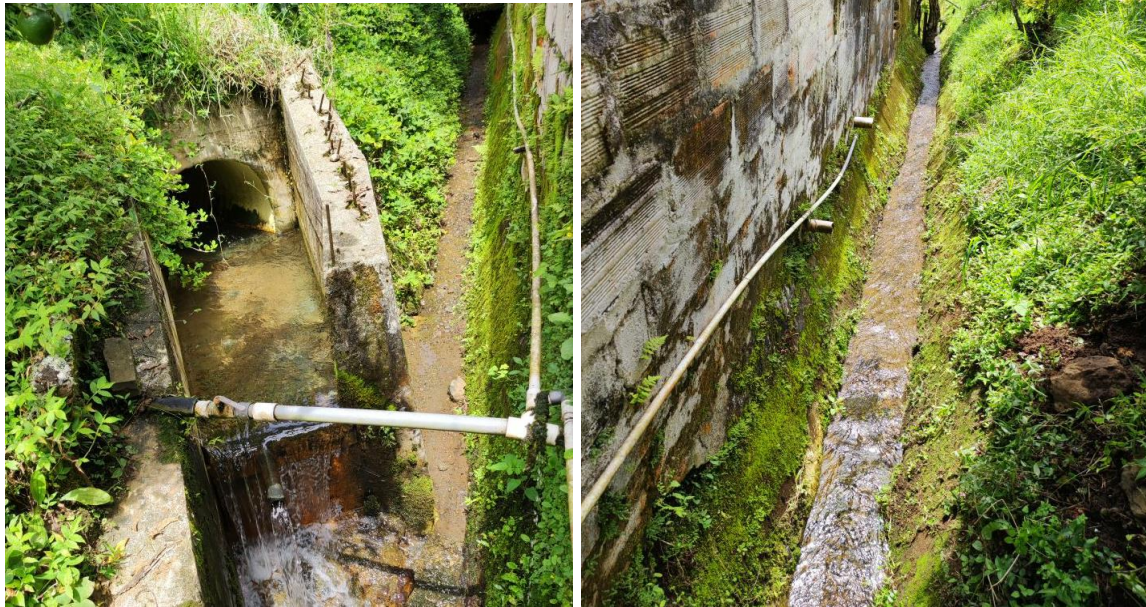
Figura 267. Canal aguas lluvias – P20.
