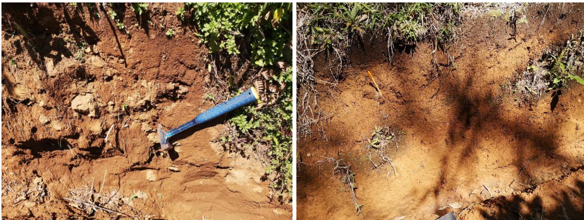
Figura 30. Afloramiento suelo residual nivel IB, talud superior de sendero de acceso al sector de la
