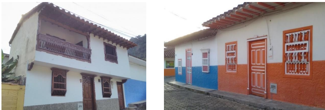
Figura 315. Tipología estructura ligera (E) en el municipio de Jericó.
