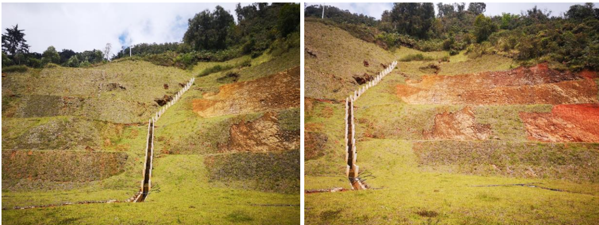
Figura 92. Movimiento en masa estabilizado en la parte alta de sector Los Aguacates.
