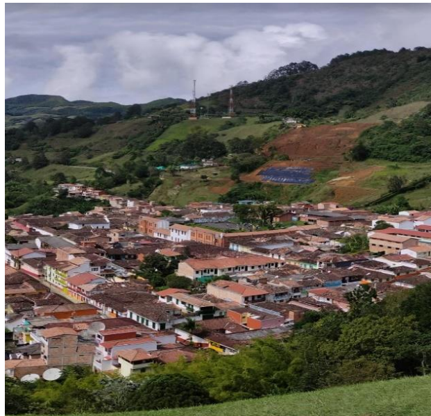
Figura 313. Zona de afectación por movimiento en masa.
