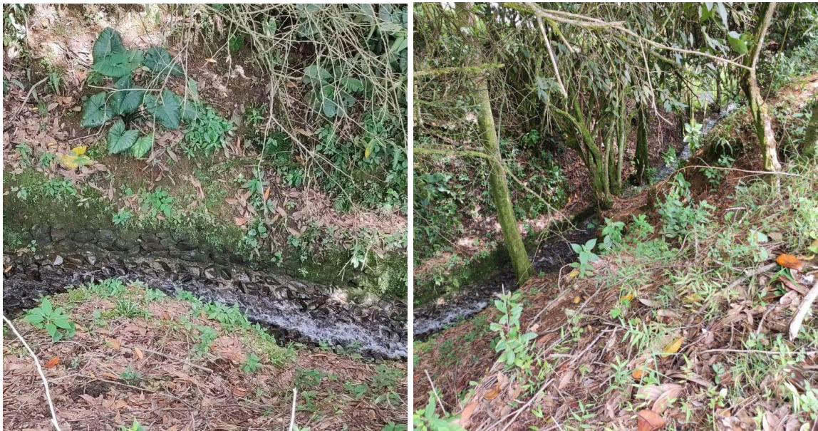
Figura 261. Canal reconformado en piedra pegada Q. La Peña – P14.
