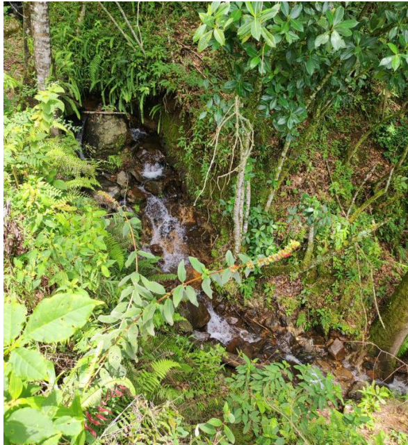
Figura 260. Procesos de incisión al interior del cauce de la Q. La Peña – P13.
