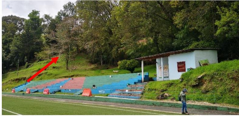
Figura 79. Panorámica unidad de ladera convexa corta y abrupta, talud superior de cancha de fútbol
