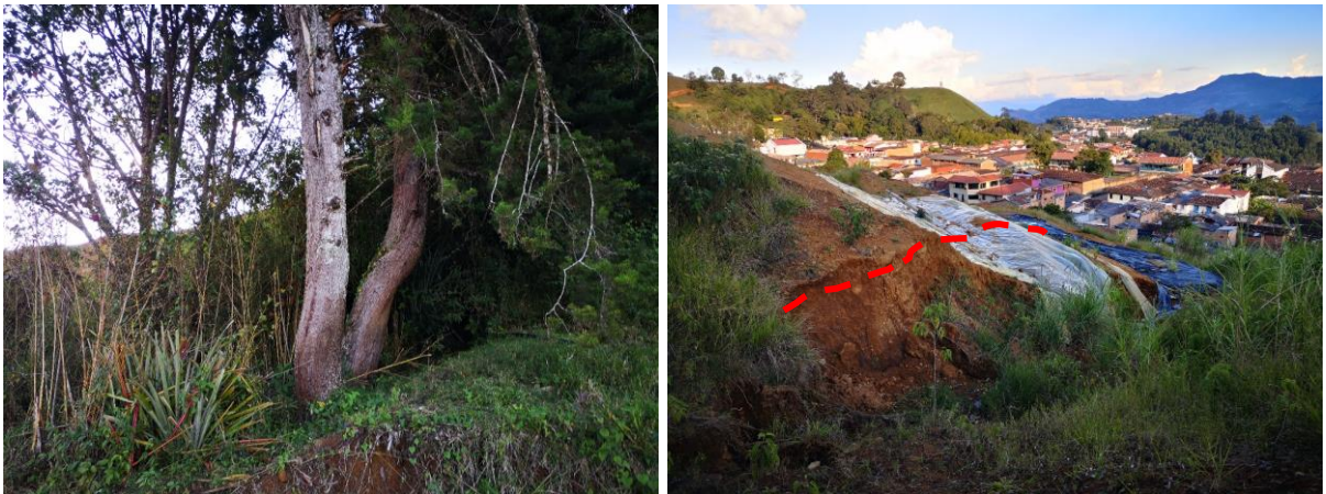
Figura 96. Evidencias que sugieren continuidad del escarpe en el flanco oriental.
