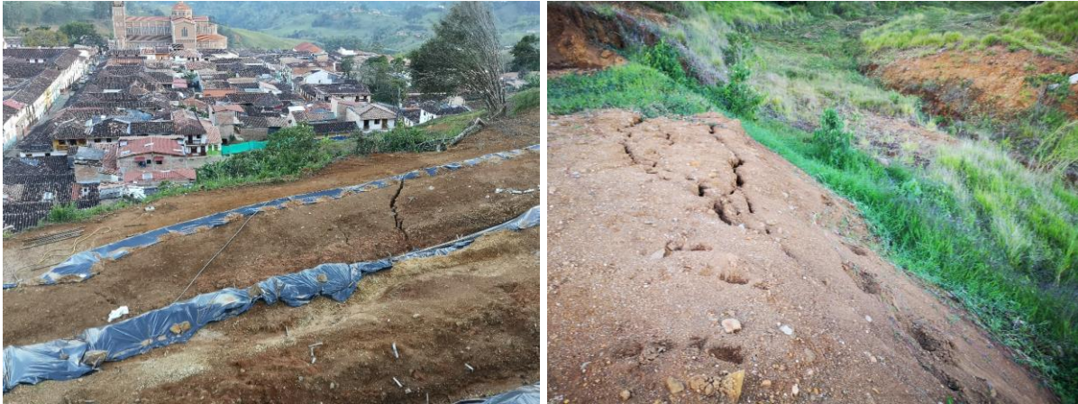
Figura 97. Agrietamiento y deformaciones identificadas el interior del movimiento en masa sobre zonas intervenidas
