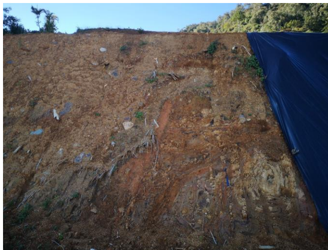
Figura 48. Afloramiento de lleno antrópico sobre talud del sector de Los Aguacates
