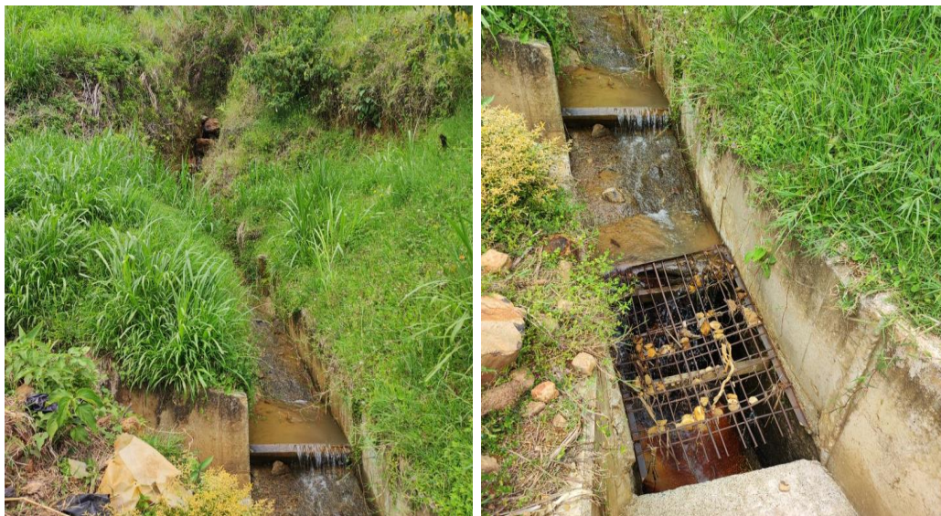
Figura 252. Conformación del cauce de la Q. La Comba en la zona de confluencia al sistema de alcantarillado – P6.
