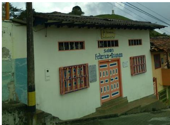
Figura 316. Tipología estructura confinamiento deficiente e híbridas (D) en el municipio de Jericó.
