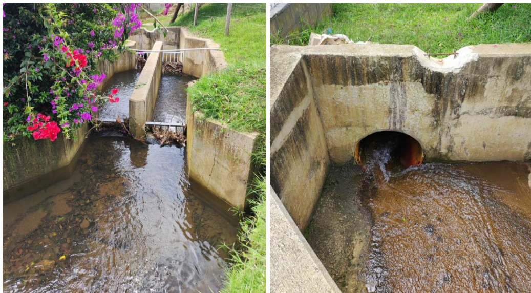
Figura 268. Obra de amortiguación de creciente de la Q. La Peña en la entrada al sistema de alcantarillado – P21.
