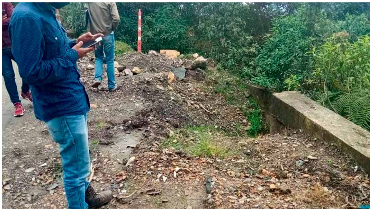
Figura 14. Inspección visual de una alcantarilla localizada en la vía Chiquinquirá-Otanche y registro de datos en campo por dispositivo móvil, incluyendo dimensiones de la sección transversal, estado de conservación, integridad de la estructura, procesos de erosión e inestabilidad del talud
