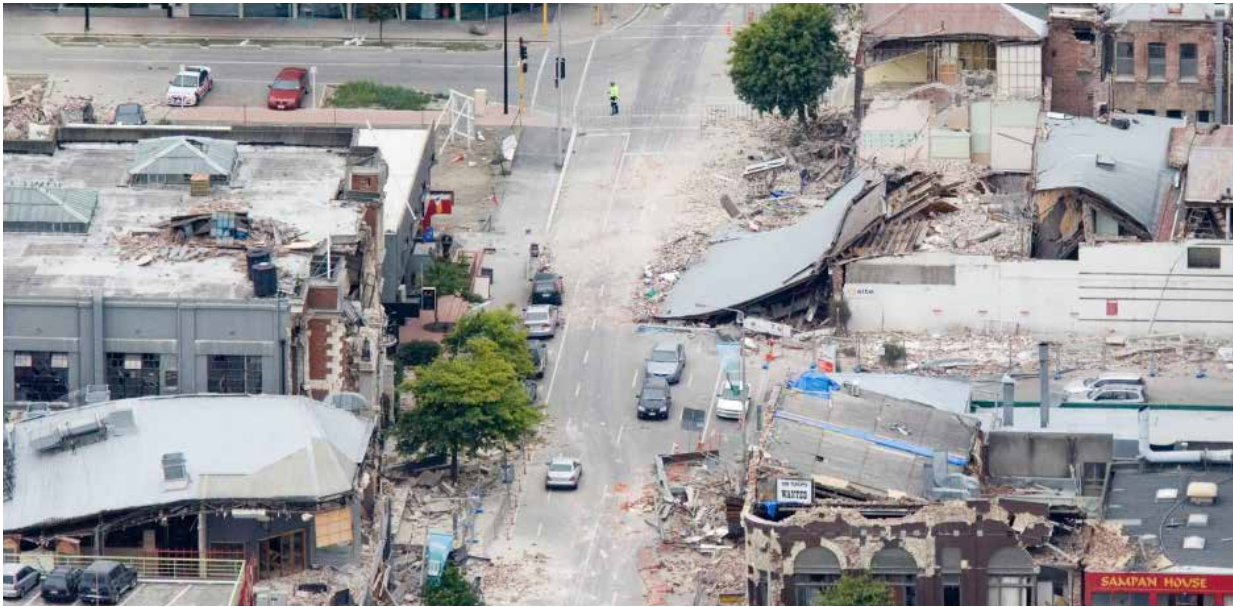
Figura 2. Representación del nivel de desempeño normativo para un conjunto de edificaciones. Adaptado de [23–25].
