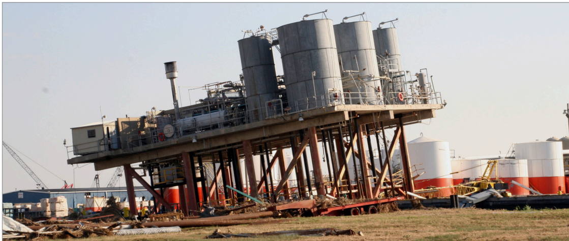
a) Daño a plataforma en refinería de petróleo en Louisiana, Foto: Robert Kaufmann, FEMA. Fuente: The U.S. National Archives.
