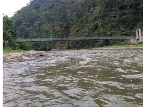
La Unidad Nacional para la Gestión del Riesgo de Desastres –UNGRD- con su proyecto “Puentes de la Esperanza y la Prosperidad”, instaló una estructura completamente metálica, bautizada por la gente “El Nuevo Diviso” o “Llano Nuevo”, la cual reemplaza un viejo puente de madera que colapsó en 2012. Con este nuevo paso 60 familias podrán cruzar de manera segura el río Catatumbo.
