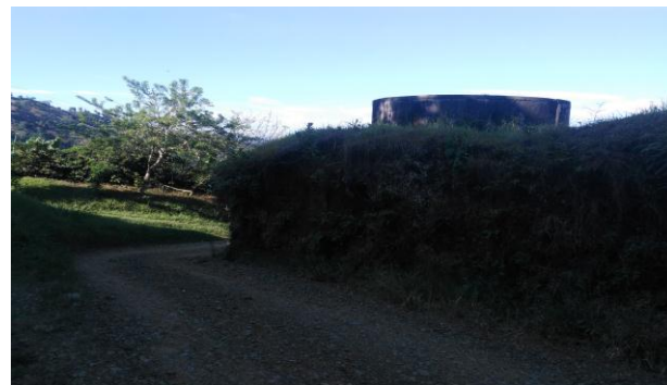
Tanque de abastecimiento - Vereda Belmonte
