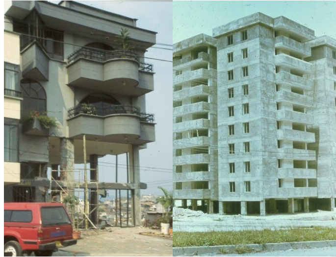
a) Piso débil con doble altura
