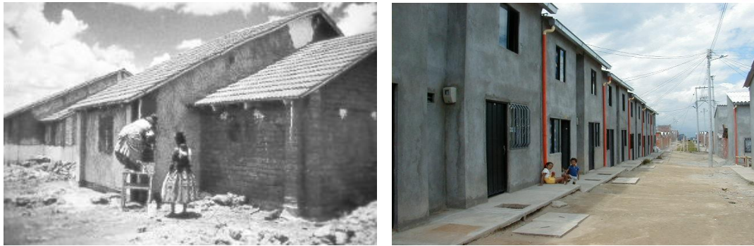
Fotografía 3-5. Edificación construida en tapia (izq.) y en bahareque encementado (der.)
