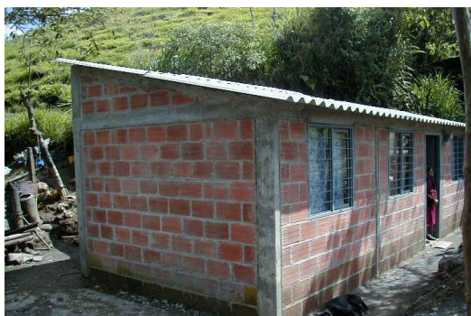
Fotografía 3-2. Edificación construida en mampostería confinada
