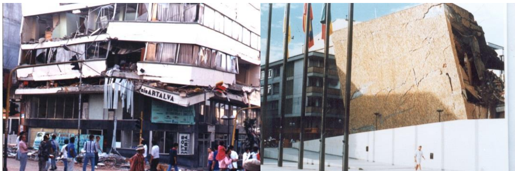
Fotografías 3-8. Colapso total de edificaciones
