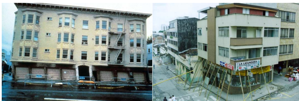
Fotografías 3-9. Inclinación de la edificación o de un entrespiso
