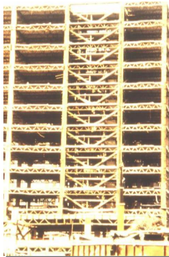
Pórticos en celosía
