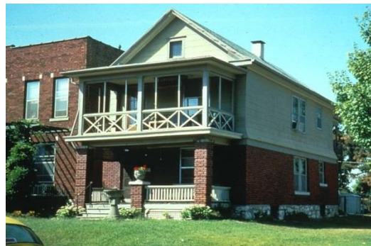
Fotografía 3-6. Edificación construida en mampostería y madera
