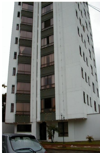
Fotografía 3-1. Edificación construida en pórticos de concreto reforzado
