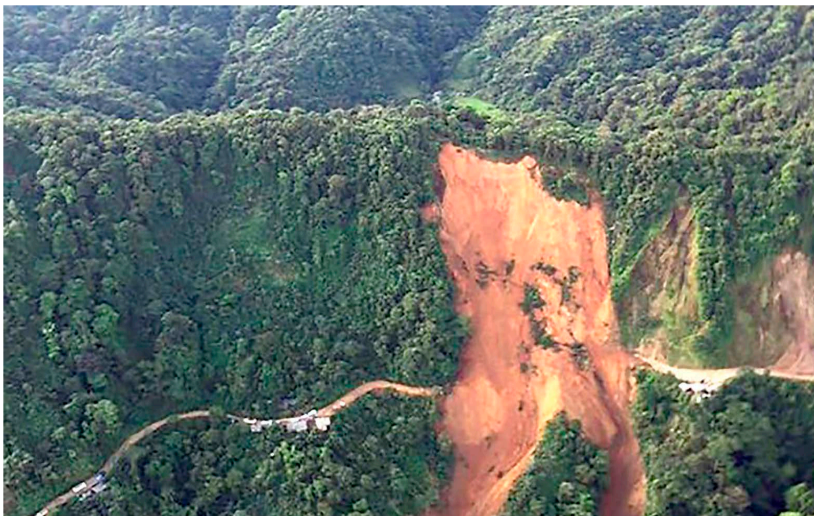
Fotografía 67. Movimiento en masa tipo deslizamiento traslacional en el municipio de Tadó (fuente: Noticias RCN, abril de 2016).
