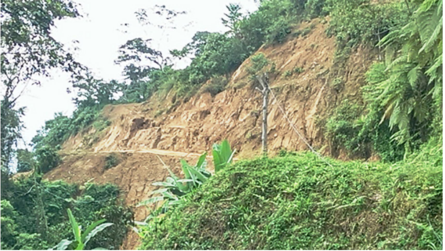
Fotografía 80. Deslizamiento rotacional localizado en el municipio de Ciénaga (tomada por la Universidad Eafit, 2013).
