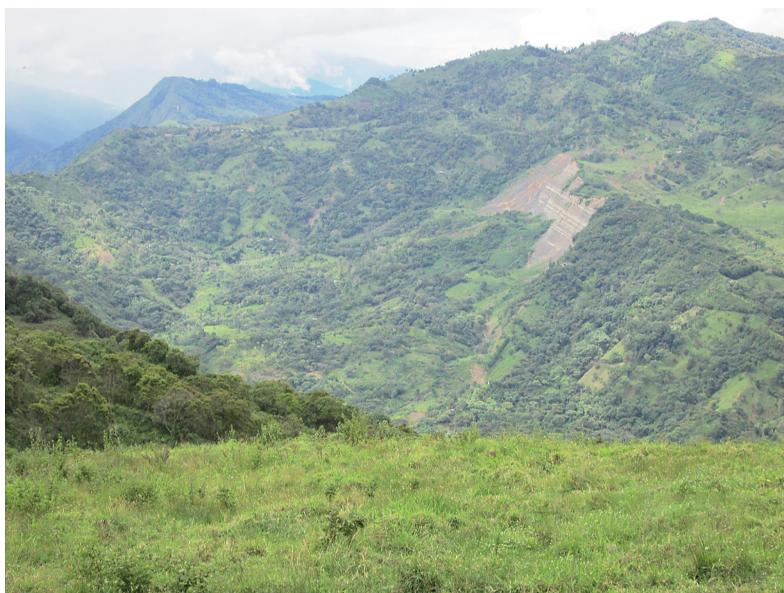
Fotografía 87. Movimiento en masa compuesto, consta de un deslizamiento traslacional con flujo de detritos en inmediaciones de las veredas Paramito y Pedro Alonso del municipio de Labateca (clasificación y fotografía por Diego Yónathan Hernández, UIS, 2013).
