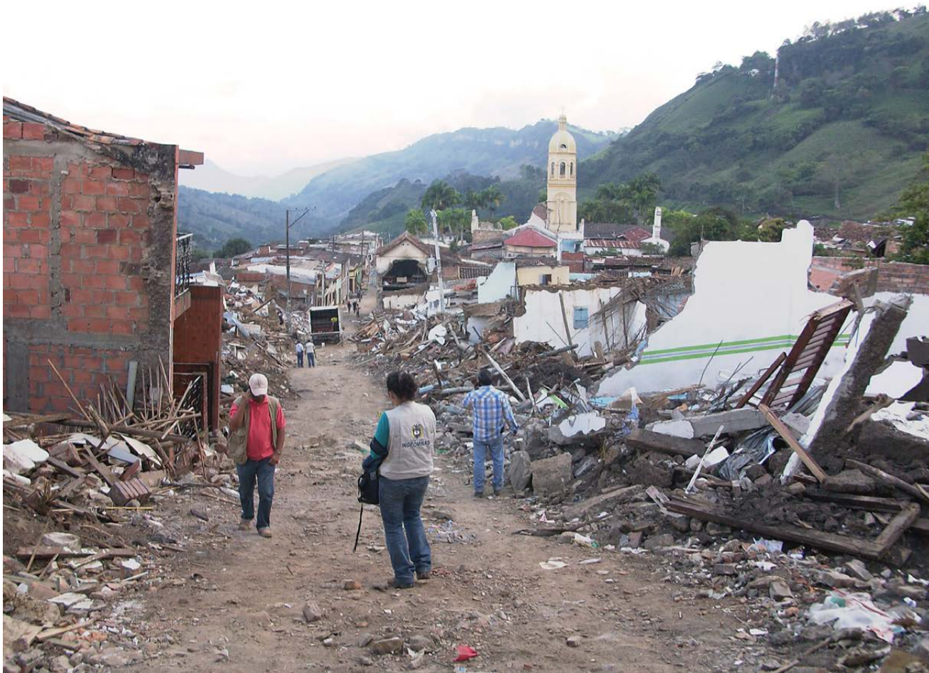
Fotografía 86. Ruinas del casco urbano del municipio de Gramalote destruido por un movimiento en masa (Fuente: SGC, 2012).
