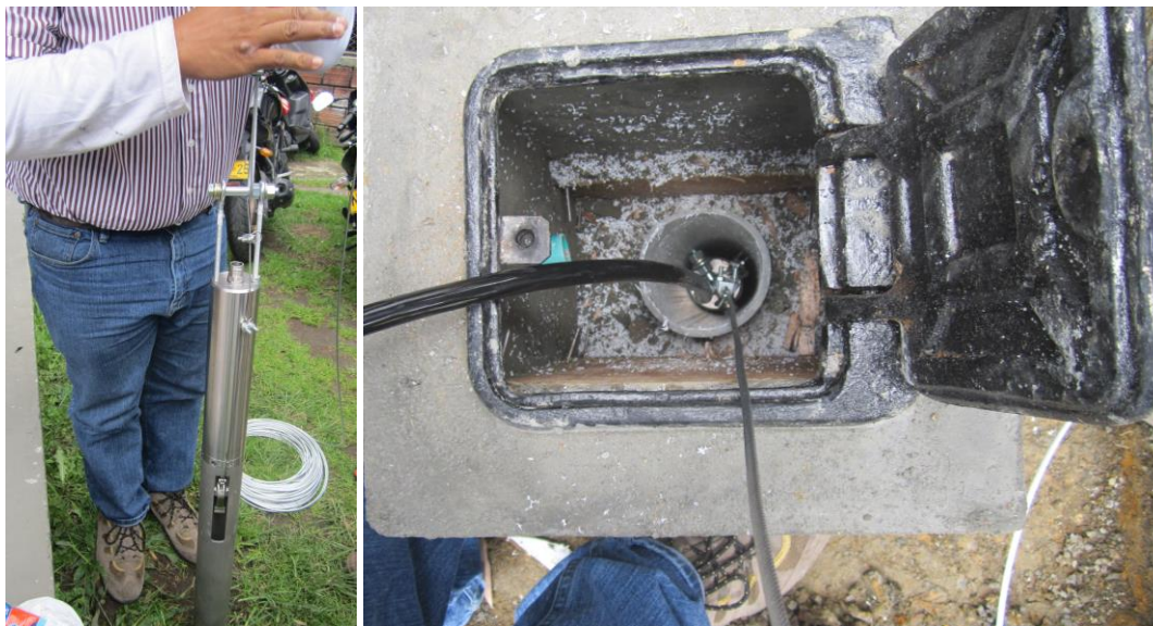
Figura 7-1 Instalación del BoreHole
