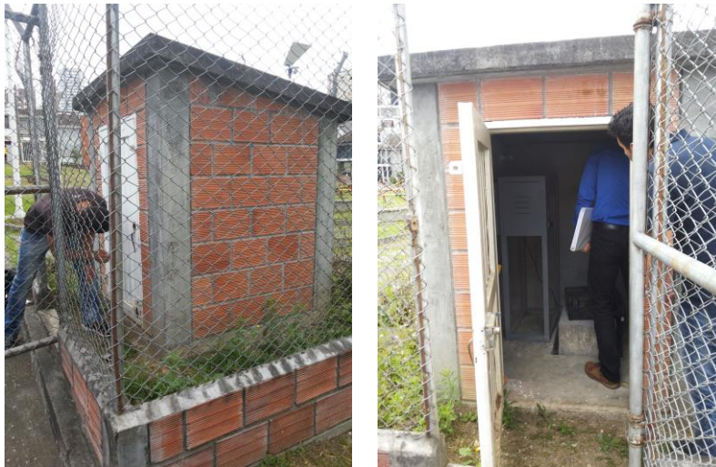
Figura 2-7 Fotografía actual Estación Palermo
