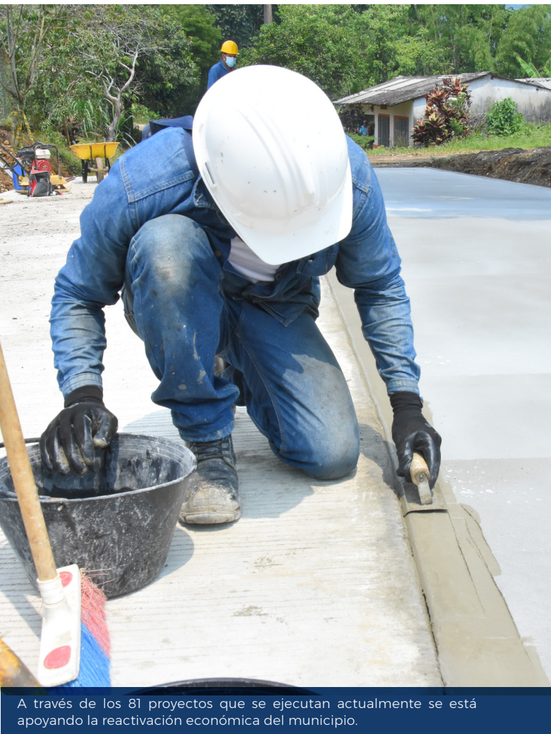
13 contratos de obra se tienen para la intervención de vías y pavimentación de las mismas.
