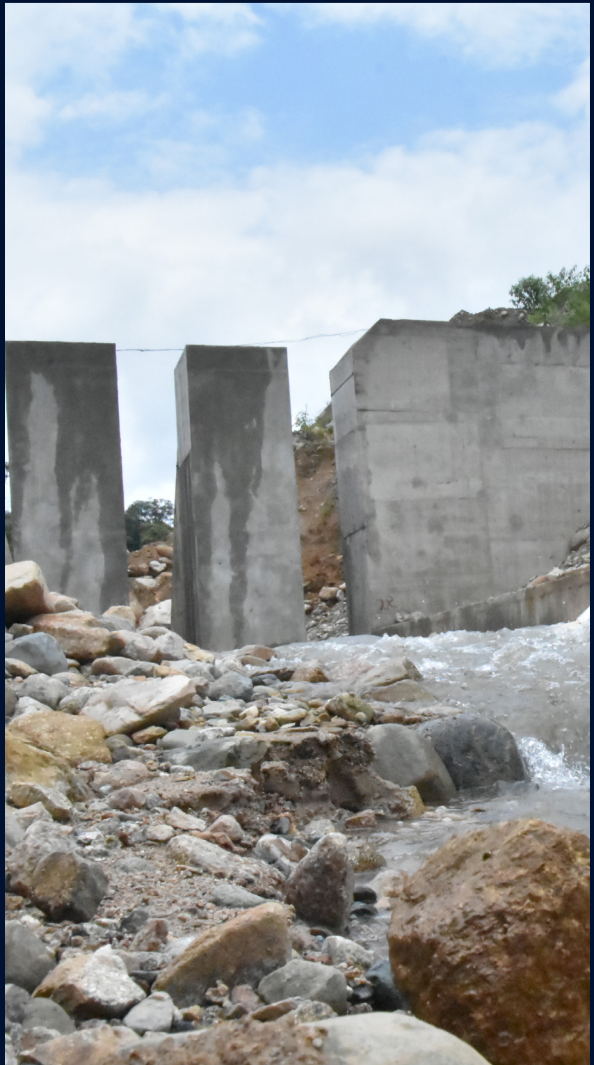
Casi un 45% de avance llevan de ejecución las obras de mitigación de la parte baja.
