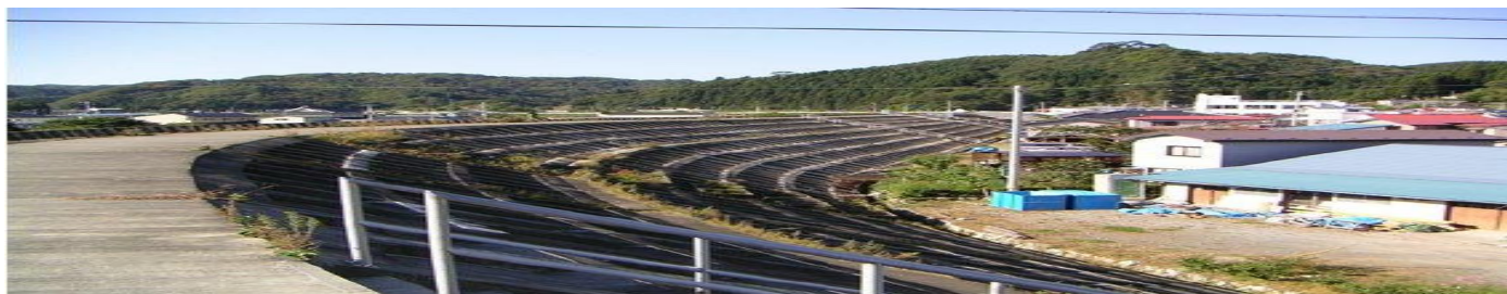
Barrera de contención, con escaleras como ruta de evacuación, usada para proteger un pueblo costero contra la inundación por tsunami en Japón. Fotografía por ciudad de Miyako, 2010. ↗
