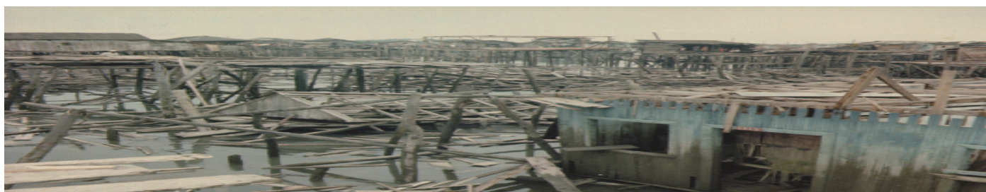
Destrucción viviendas paratíficas en madera por tsunami de Tumaco (Nariño). Fuente: Hansjürgen Meyer, 1979 ↗
