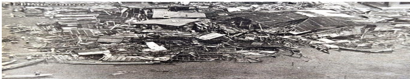
Destrucción viviendas paratíficas en madera por tsunami de Tumaco (Nariño) – Vista área Fuente: colombia.com
