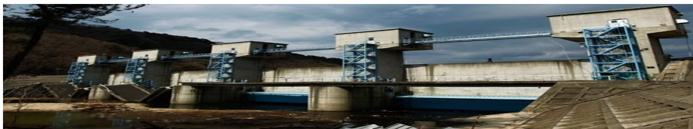
Esclusa usada como protección contra las ondas de tsunami en Fudai, Iwate, Japón. La compuerta comienza a cerrarse automáticamente unos segundos después de que el movimiento telúrico active los sensores sísmicos. Fotografía por AP ↗
