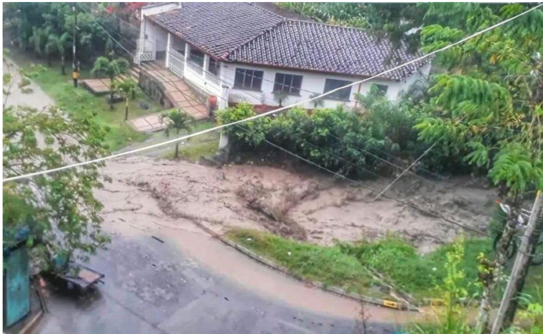
Figura 3. Instante en el que el caudal de la quebrada Desmotadora supera la capacidad hidráulica del puente, forma un remanso y el agua empieza a correr por la Carrera 11 (Murillo Toro) ( 7^{\circ}0'11,2''N - 76^{\circ}16'7,4''W ). Foto: Dapard (2018), tomada y adaptada de RCN Radio, 2018 .
