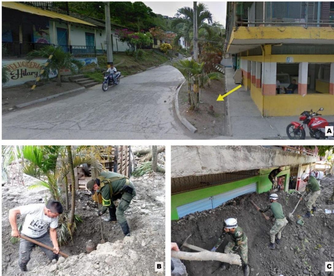
Figura 7. Secuencia del antes y después en la Plaza Municipal de Mercado: A) Esquina de la Plaza, la flecha señala el hidrante ( 7^{\circ}0'9,4''N - 76^{\circ}16'4,9''W ) y en sentido SW la Carrera 11. Fuente: Google Earth, 2013. B) Un par de personas retira el sedimento que cubrió el hidrante, Fuente: Twitter Cr Heiner Giovanni Puentes Aguilar. C) Personal militar retira el sedimento que cubrió las rejas ( 7^{\circ}0'8,6''N - 76^{\circ}16'5,1''W ), Fuente: Twitter Cr Heiner Giovanni Puentes Aguilar.
