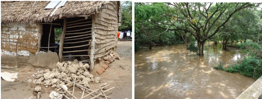
Figura 30. Damnificados por la ola invernal en Veracruz. En las fotografías superiores se observa la destrucción de los techos (láminas de zinc) y en la parte inferior derecha el desbordamiento del río, inundando todas las zonas aledañas.
