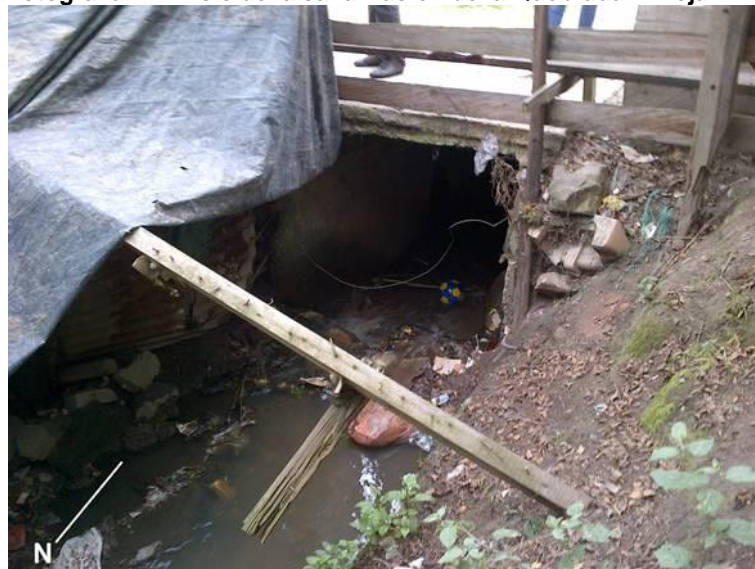
Fotografía 4.4 Inicio de la canalización de la Quebrada El Tejar
