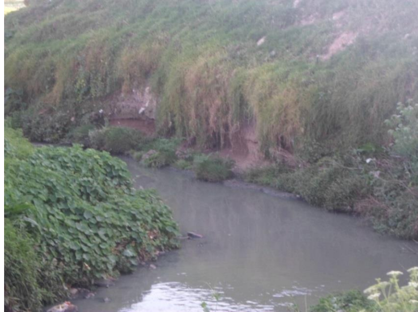
Fotografía 4.1 Socavación del Rio Negro sobre suelos y áreas cercanas a Postobón.
