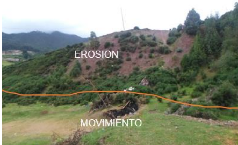
Fotografía 5.2 Laderas afectadas por erosión.
