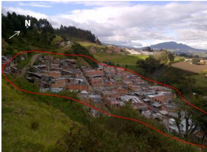
Fotografía 5.8 Panorámica del Barrio Bolívar 83 en coordenadas N 1048430 y E 1007406.
