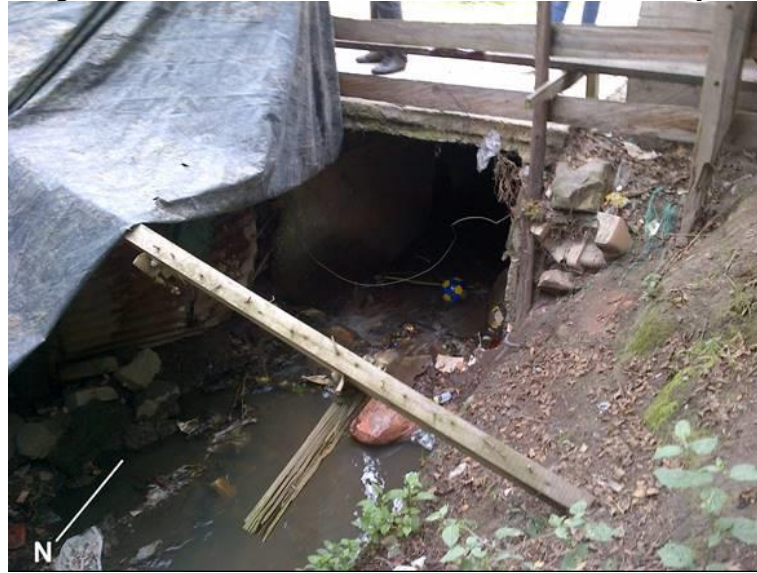
Fotografía 5.12 Inicio de la canalización de la Quebrada El Tejar
