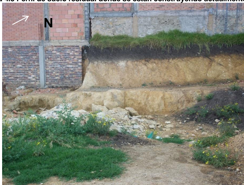
Fotografía 4.3 Perfil de suelo residual donde se están construyendo actualmente viviendas.
