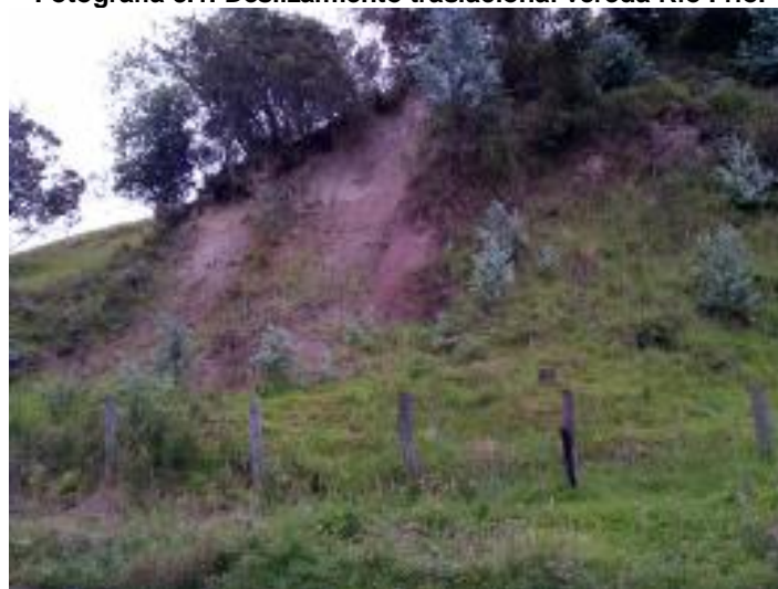
Fotografía 3.1. Deslizamiento traslacional vereda Río Frío.
