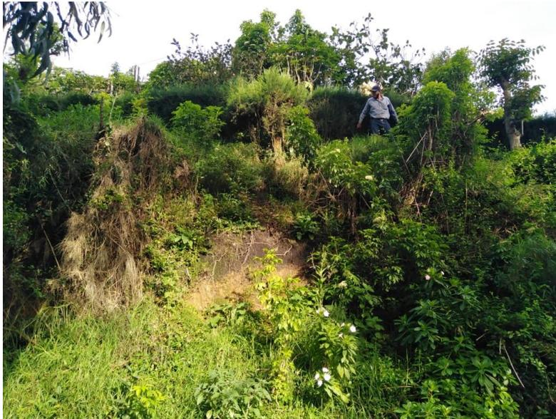
**Fotografía 27. Remoción en masas ocasionadas posiblemente por el corte del terreno, las altas pendientes y el cambio de cobertura del suelo. (Punto Vereda San Jorge).**
