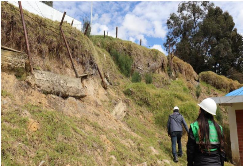
**Fotografía 26. Movimiento en masa generado posiblemente por los cortes del terreno que se habían efectuado. (Punto Fundación Esperanza).**
