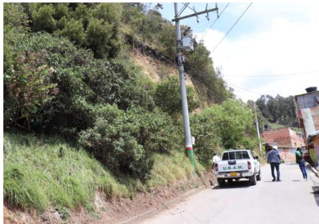
**Fotografía 20. Movimiento en masa posiblemente de tipo deslizamiento, en el cual se puede observar la forma de la falla. (Punto Barrio Bolívar 83).**
