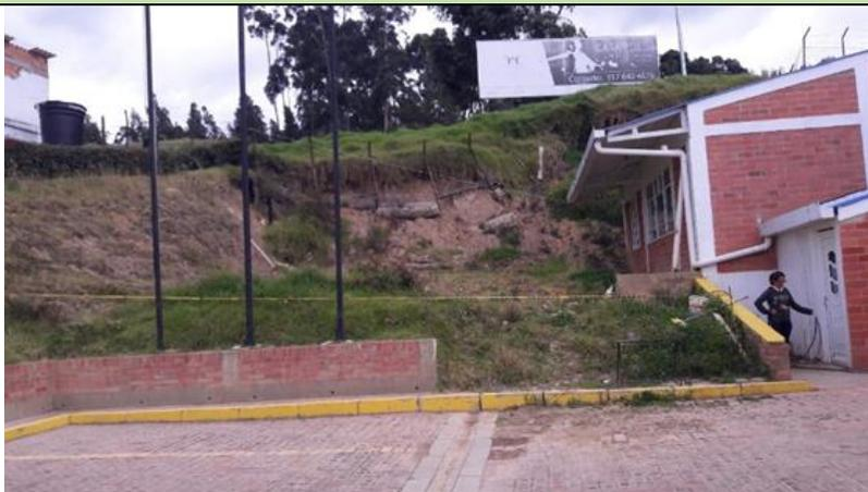
**Fotografía 25. Movimiento en masa generado posiblemente por los cortes del terreno que se habían efectuado. (Punto Fundación Esperanza).**
