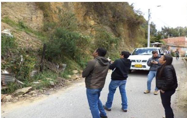
**Fotografía 19. Movimiento en masa posiblemente de tipo deslizamiento, en el cual se puede observar la forma de la falla. (Punto Barrio Bolívar 83).**
