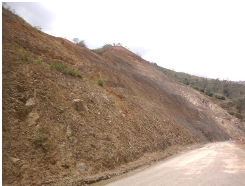
Figura 7. Taludes verticalizados que ha sufrido desprendimientos de materiales en el tramo vial Santuario – Apía.
