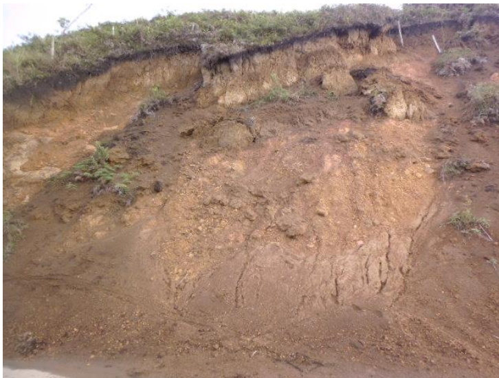
Figura 5. Vía san José – Risaralda, sector Quiebra de varillas. Proceso activo con erosión concentrada en surcos hacia la parte baja.
