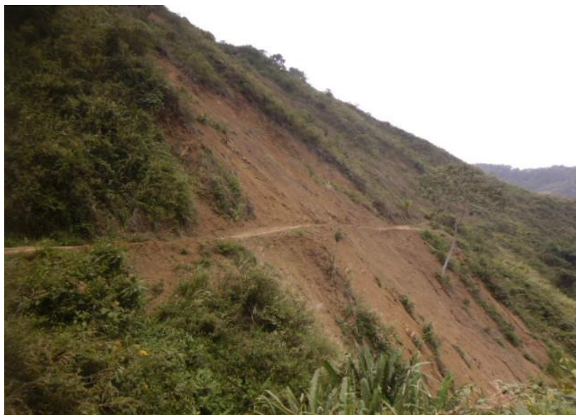
Figura 44 Movimiento en masa afectando vía secundaria (Belén de umbría – Mistrató), entre las veredas providencia – La Llorona Fuente. Consorcio Ordenamiento Cuenca Risaralda 2016.
