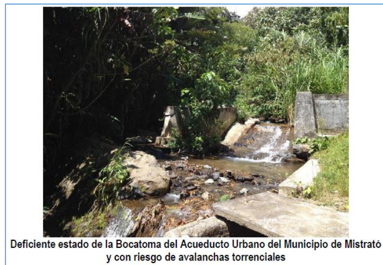
Figura 47. Bocatoma acueducto urbano del municipio de Mistrató
