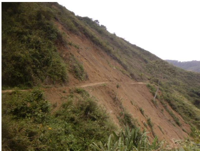
Figura 3. Movimiento en masa afectando vía secundaria (Belén de umbría – Mistrató), entre las veredas providencia – La Llorona.
