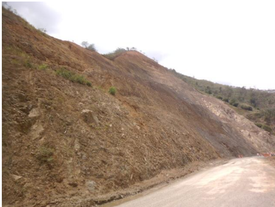
Figura 21 Taludes verticalizados que ha sufrido desprendimientos de materiales en el tramo vial Santuario – Apía
