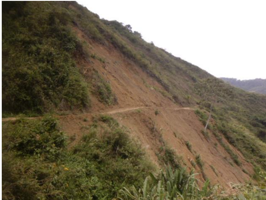
Figura 17 Movimiento en masa afectando vía secundaria (Belén de umbría – Mistrató), entre las veredas providencia – La Llorona
