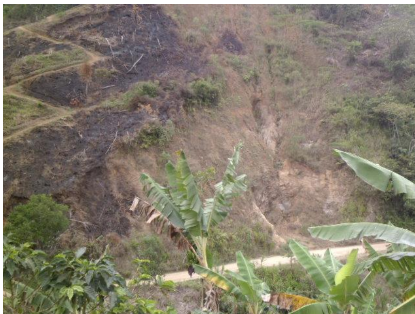
Figura 6. Vía mateguadua- vereda Al Abejero (Vía Belen-Mistrato), movimiento rotacional con presencia de erosión laminar por acción de escorrentía superficial, se observa fuerte carcavamiento.
