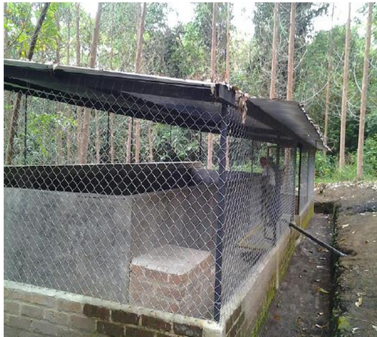
Figura 42. Desarenador principal (cerramiento y techado), acueducto municipal de Guática
