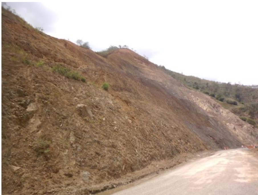
Figura 48 Taludes verticalizados que ha sufrido desprendimientos de materiales en el tramo vial Santuario – Apía Fuente. Consorcio Ordenamiento Cuenca Risaralda 2016.
