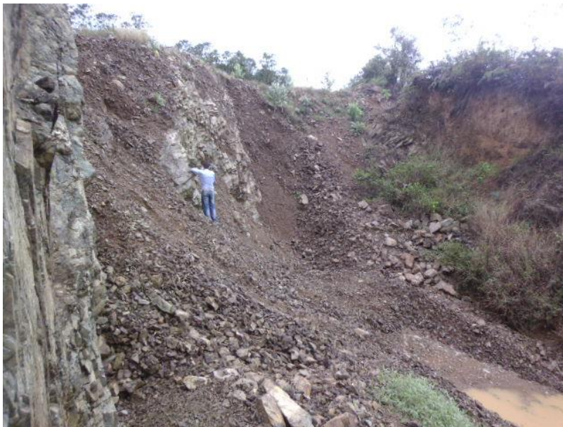
Figura 9. Cantera ubicada sobre la vía San José – Risaralda. Nótese el flujo de detritos que forma depósitos tipo talus.
