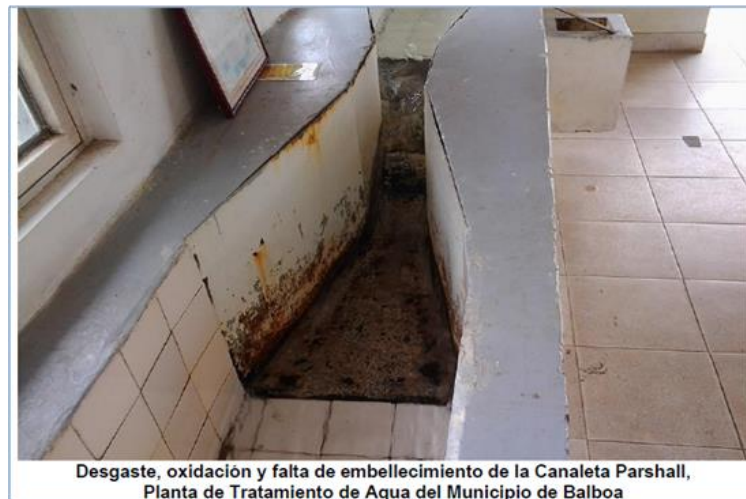
Figura 39. Canaleta Parshall, PTAP, municipio de Balboa
