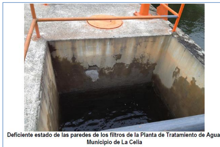
Figura 44. Filtros PTAP, municipio de La Celia
