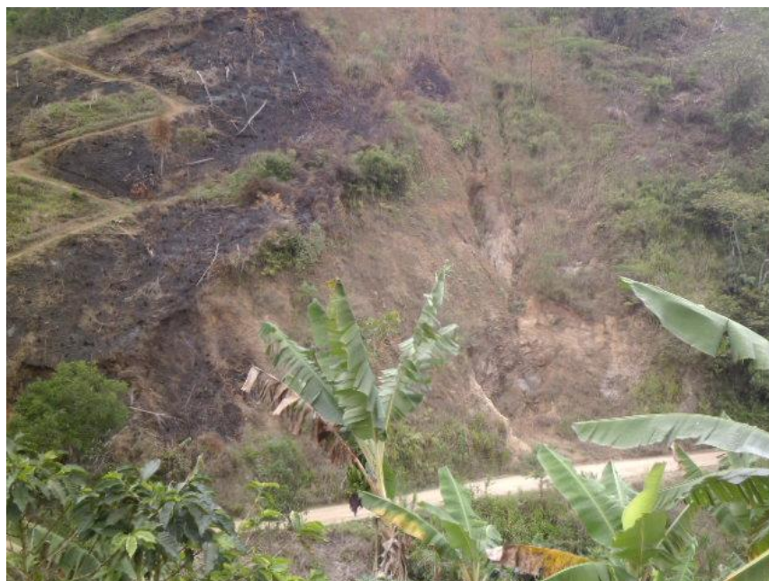
Figura 47 Vía Mateguadua - vereda Al Abejero (Vía Belén-Mistrató), movimiento rotacional con presencia de erosión laminar por acción de escorrentía superficial, se observa fuerte carcavamiento
