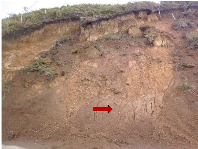
Figura 46 Vía san José – Risaralda, sector Quiebra de varillas. Proceso activo con erosión concentrada en surcos hacia la parte baja.
