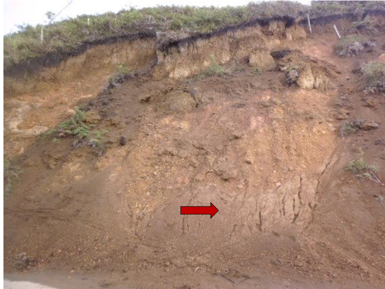
Figura 19 Vía san José – Risaralda, sector Quiebra de varillas. Proceso activo con erosión concentrada en surcos hacia la parte baja.
