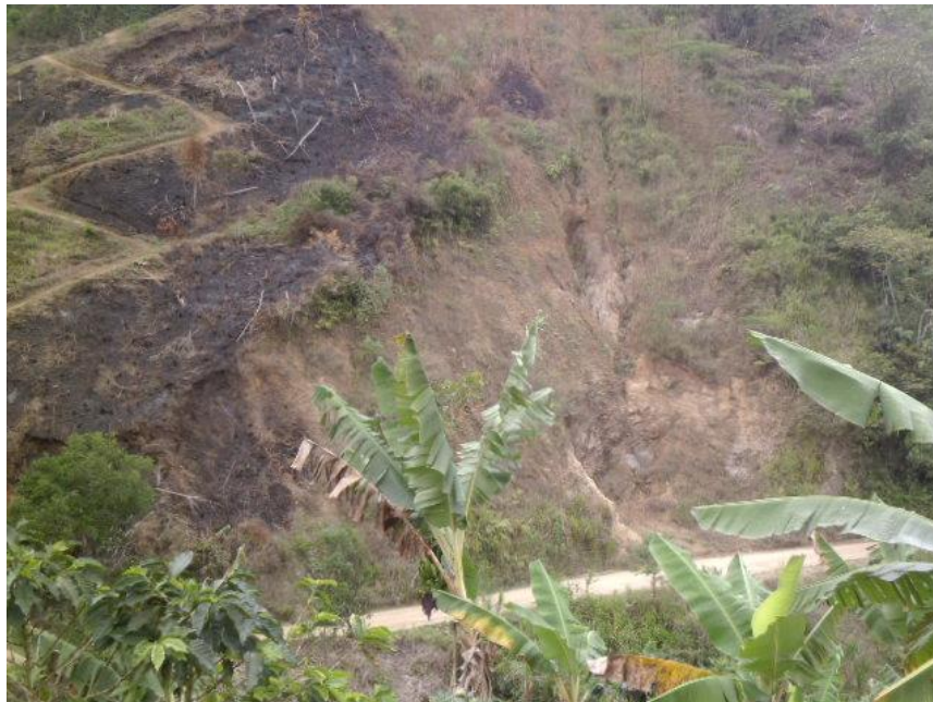
Figura 20 Vía Mateguadua - vereda Al Abejero (Vía Belén-Mistrato), movimiento rotacional con presencia de erosión laminar por acción de escorrentía superficial, se observa fuerte carcavamiento
