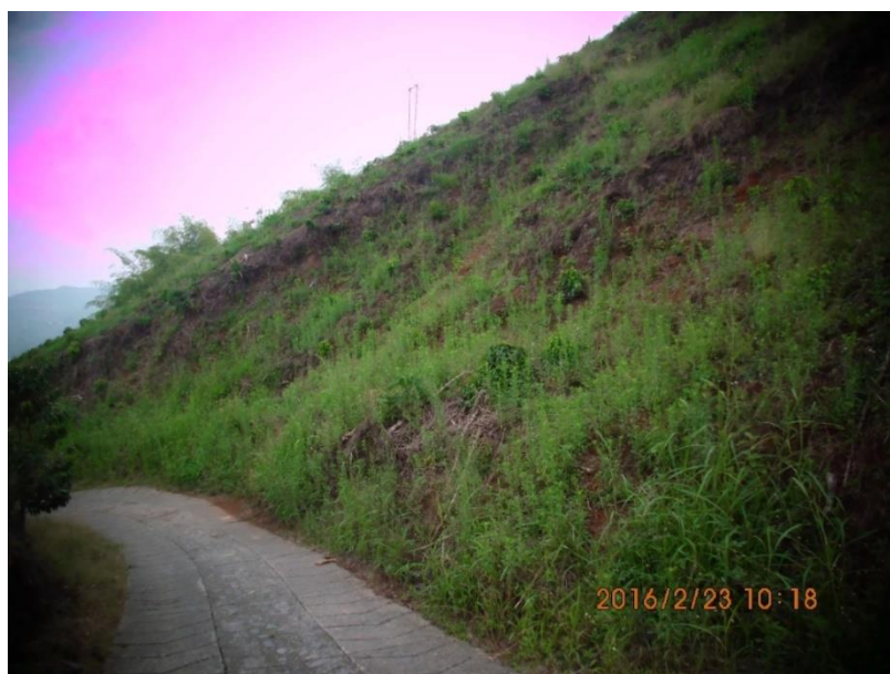
Figura 2. Movimiento en masa antiguo registrado en la vereda Buenos Aires perteneciente al municipio de Belalcázar, Caldas.
