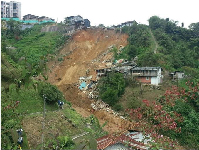
Figura 6. Deslizamiento rotacional en Manizales (Caldas), fuente: UNGRD, (2013).
