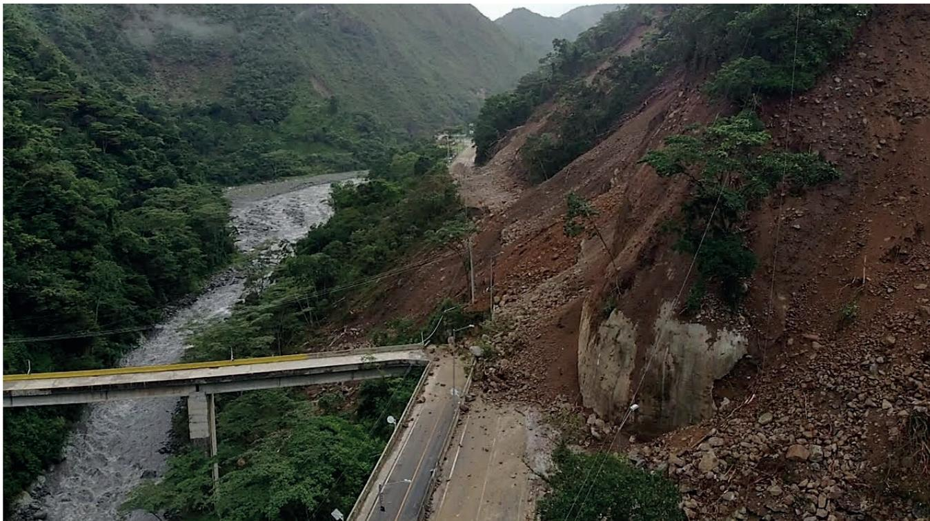
**Figura 28.** Movimiento en masa complejo que obstruyó totalmente la vía al llano a la altura del municipio de Guayabetal (Cundinamarca)
