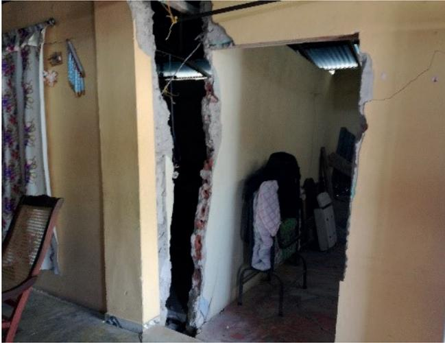
Grietas en los muros y fachadas, frecuentemente las grietas han sido reparadas en varias ocasiones y se han vuelto a abrir.
