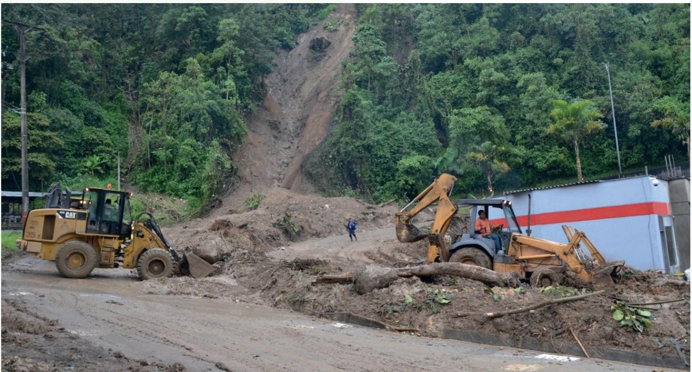
**Figura 21.** Movimiento en masa mixto, deslizamiento traslacional y flujo de lodo, detonados por lluvias en Manizales (Caldas), fuente: UNGRD (2017).
