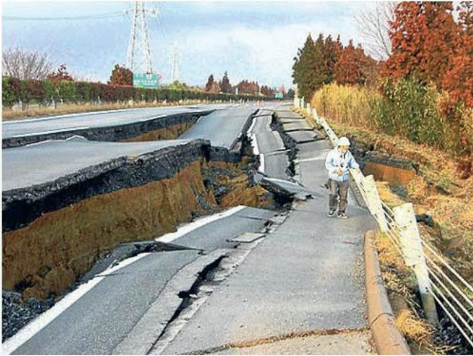
Figura 14. Propagación lateral por material blando subyacente, detonado por sismo, Japón, fuente: Tokai University.
