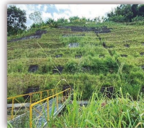
Obra con terraceo, pantallas pasivas en la parte superior, pernos de anclaje, canales laterales con columpios de tapa y 64 dados de anclaje, se encuentra en buen estado, no se observa socavación en las terrazas y no se visualizan fisuras.
