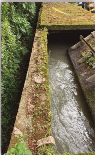
Se observa un reforzamiento estructural en la conducción con un muro de refuerzo de 10 cm en ambos lados del canal abierto.
