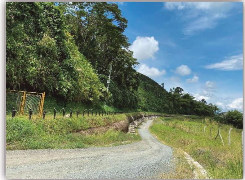
Obra con 7 cajas de instrumentación y 40 pernos de anclaje, también se elaboraron cunetas y drenajes en espina de pescado.
