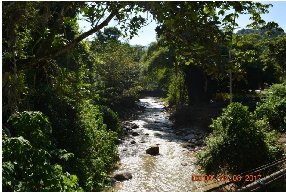
Figura 515. Deposito torrencial sobre el río Playonero
