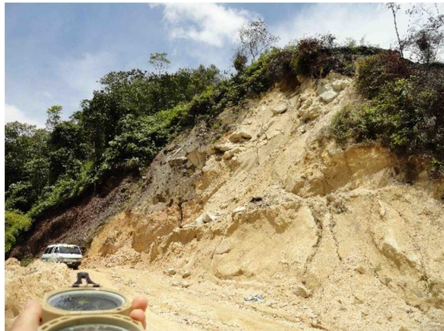
Figura 508. Deslizamiento sobre la vía a Betania
