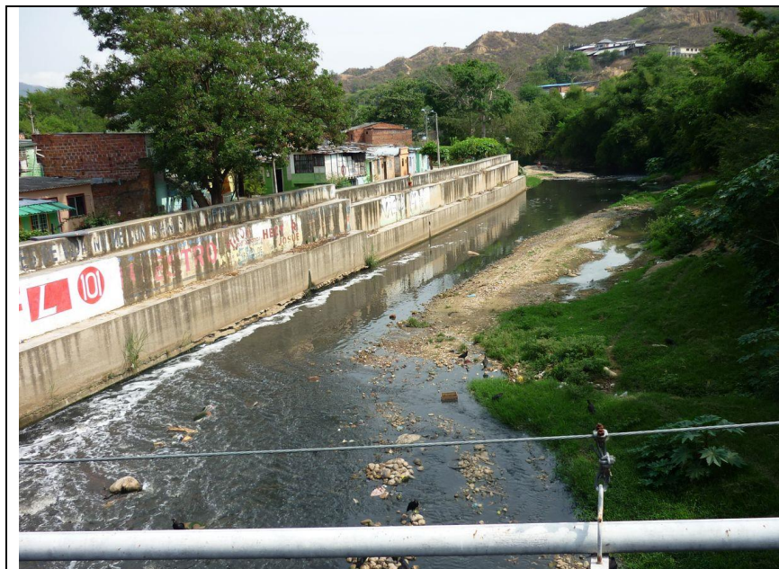
Foto 10.20 Río de Oro aguas abajo desde Puente vehicular barrio El Poblado
