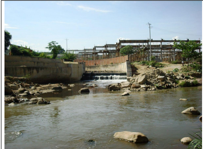
Foto 10.23 Río de Oro desde margen izquierda. Confluencia Quebrada La Iglesia
