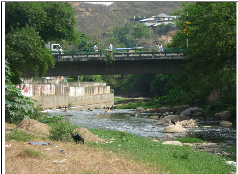
Foto 4.18 Río de Oro. Puente Vehicular Rincón de Girón
