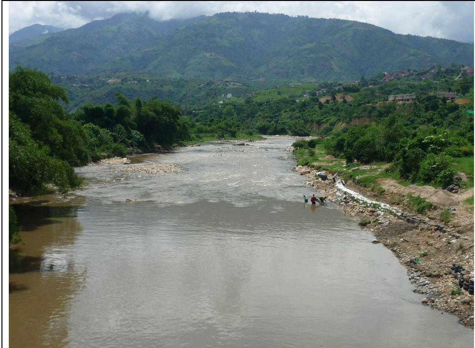
Foto 4.12 Río de Oro sector Puente vehicular Antonio Nariño hacia Café Madrid. Con un "n" de Manning calculado en el cauce de 0.038
