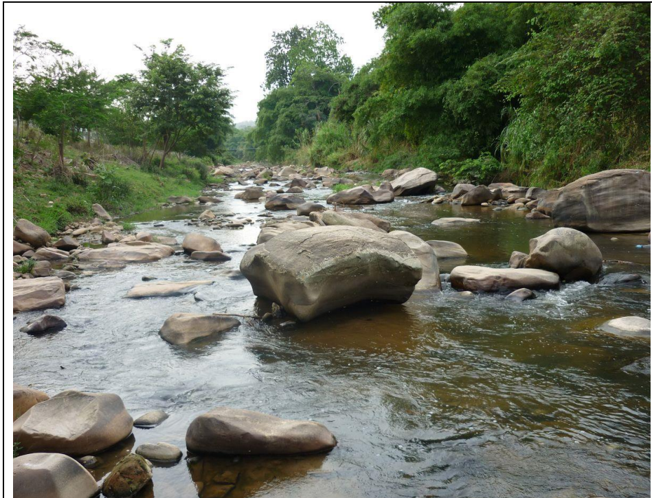
Foto 4.2 Río de Oro sector entre cr. 29 calle 10-10B a Arenales Campestre. Con un "n" de Manning calculado en el cauce de 0.055
