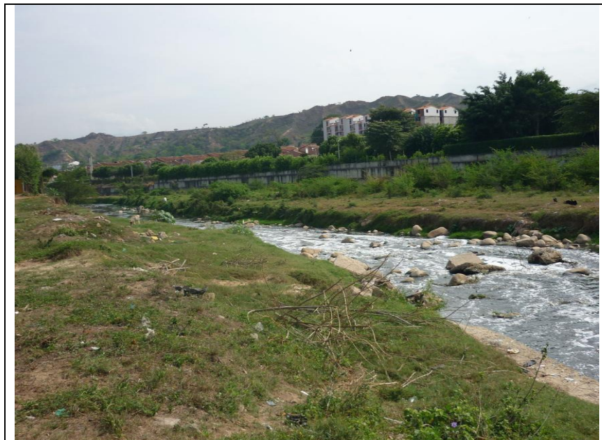
Foto 6.2 Tramo Río Frío- Q La Iglesia
