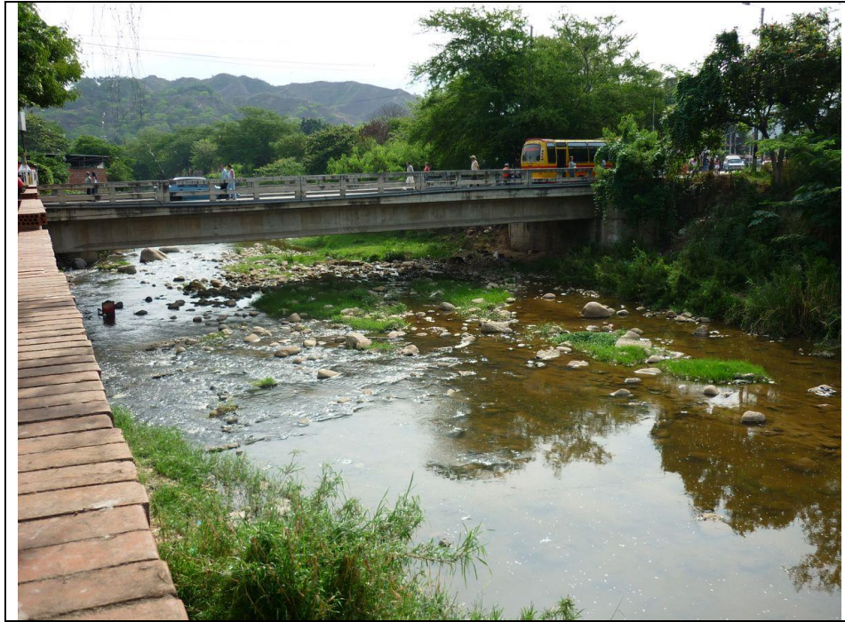
Foto 4.17 Río de Oro. Puente Vehicular Lengerke
