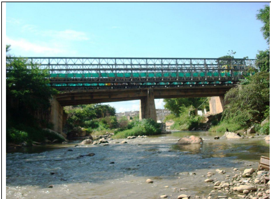
Foto 10.24 Río de Oro aguas abajo. Puente vehicular Flandes en construcción
