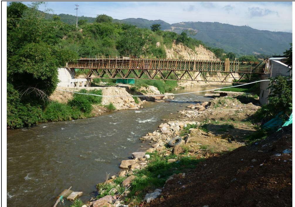
Foto 4.13 Río de Oro. Puente Vehicular Llano Grande (En construcción)
