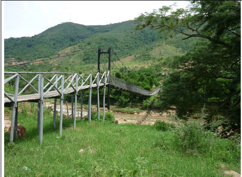
Foto 4.23 Río de Oro. Puente Peatonal Sector La Picha
