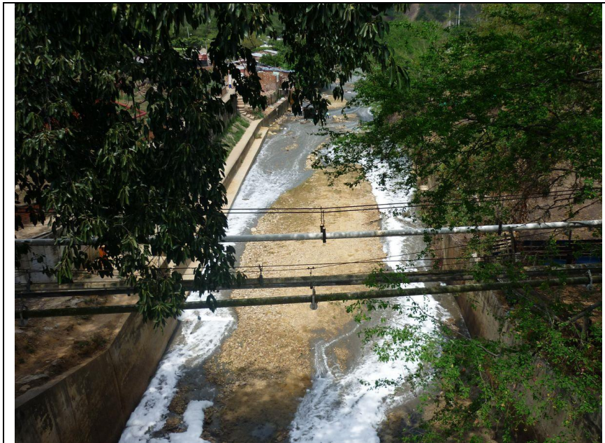
Foto 10.32 Quebrada Chimitá aguas abajo desde puente vehicular vía Palenque-Café Madrid
