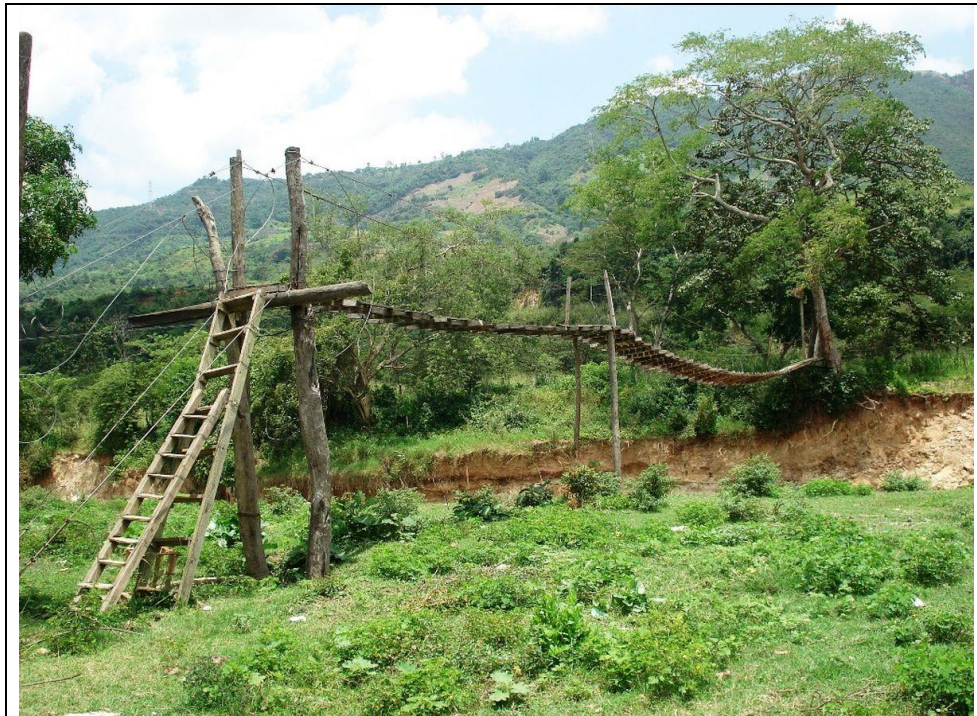
Foto 4.20 Río de Oro. Puente Peatonal Sector Almacafé
