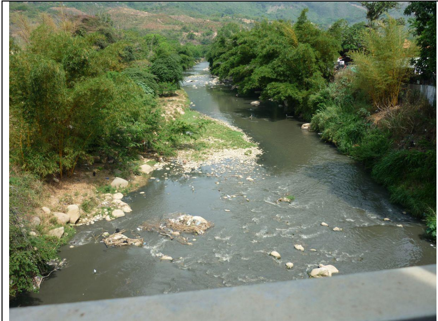
Foto 10.25 Río de Oro aguas abajo desde Puente vehicular Flandes
