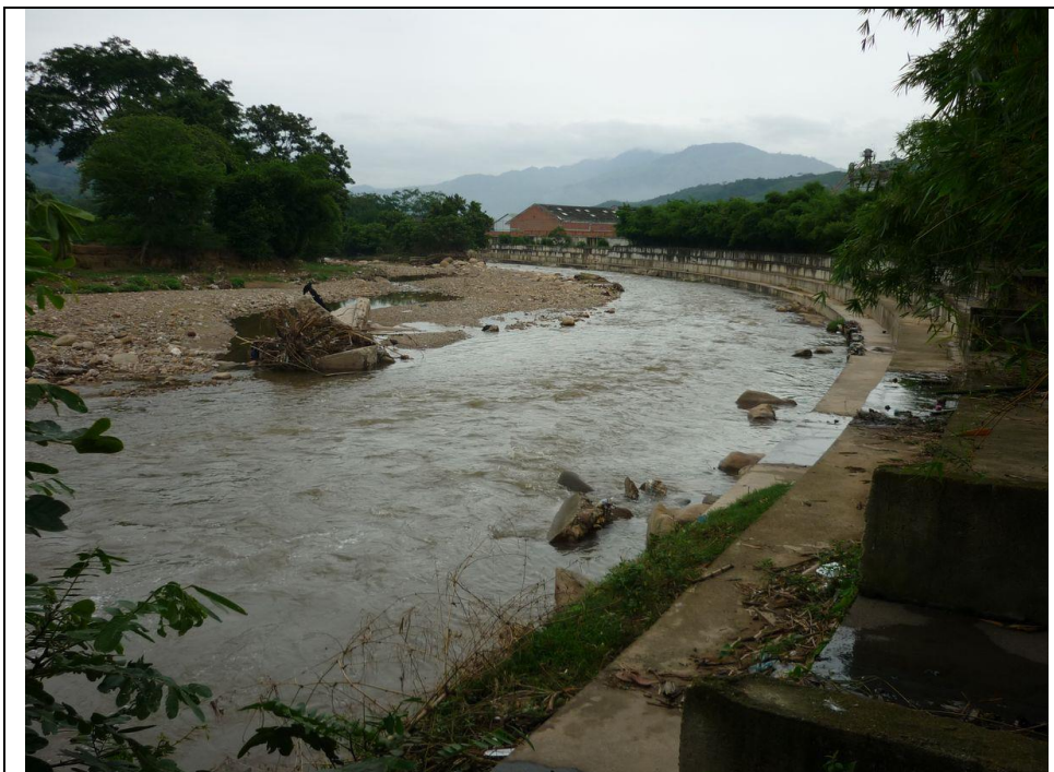
Foto 4.9 Río de Oro sector Zona Industrial. Con un "n" de Manning calculado en el cauce de 0.038
