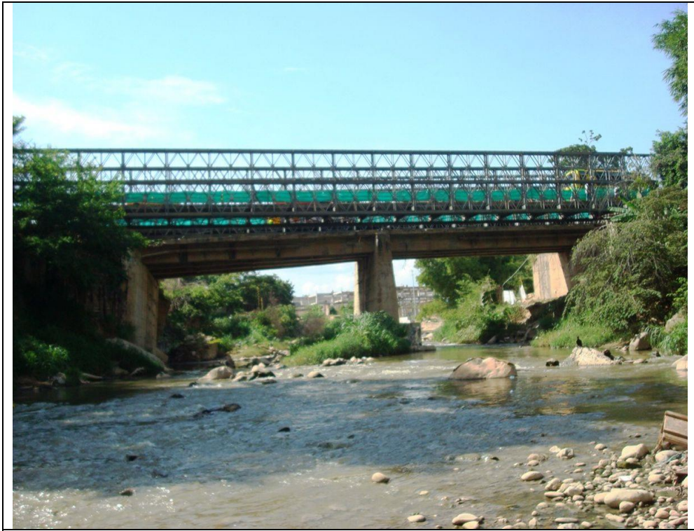
Foto 4.19 Río de Oro. Puente Vehicular Flandes (En construcción)
