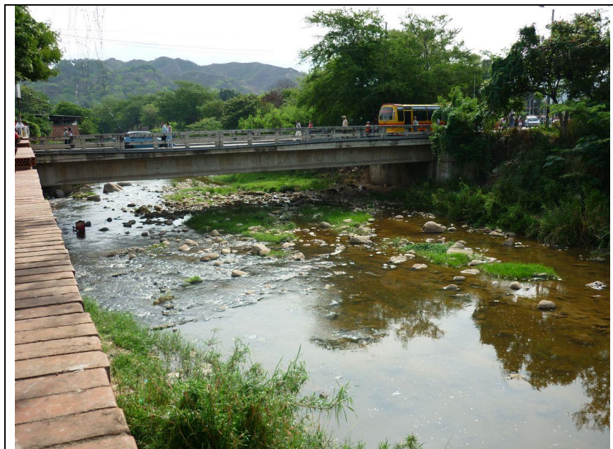
Foto 10.12 Río de Oro aguas abajo desde malecón. Puente vehicular Lengerke
