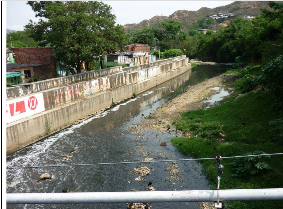
Foto 4.6 Río de Oro sector puente vehicular Rincón de Girón a Brisas del Río. Con un "n" de Manning calculado en el cauce de 0.038
