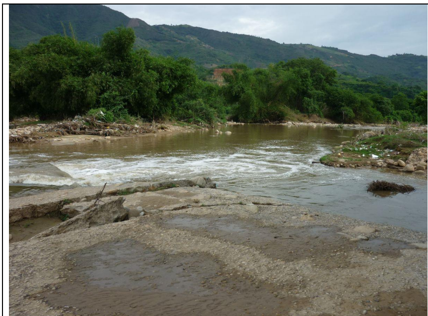
Foto 10.50 Río de Oro aguas abajo desde Batea en ruinas
