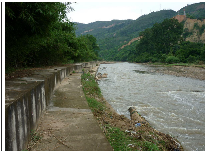
Foto 10.38 Río de Oro aguas arriba finalizando Centro Abastos
