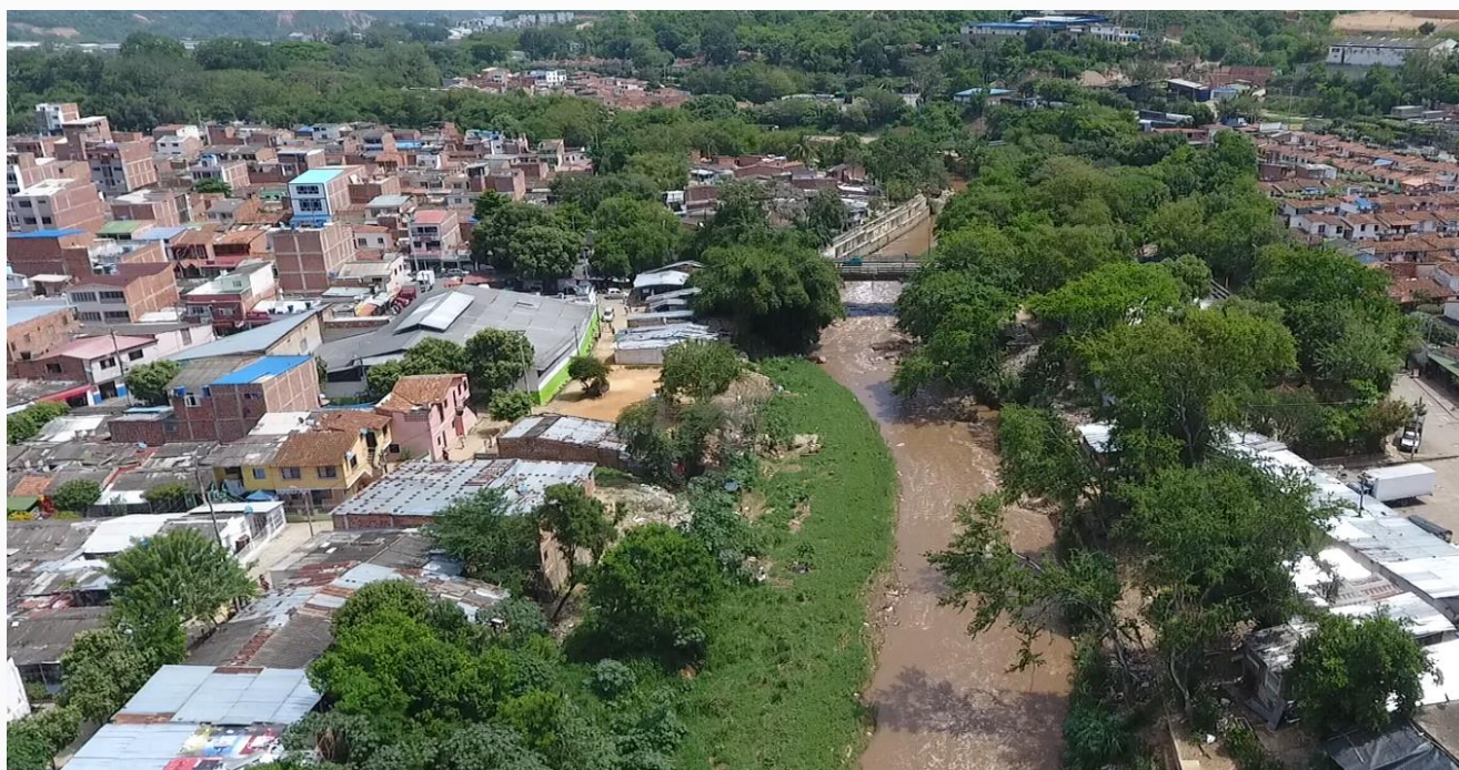
Vista de los sectores Bella Isla, El Poblado y El Carmen, sobre la margen izquierda del Río de Oro, aguas arriba del puente Eliecer Fonseca.
