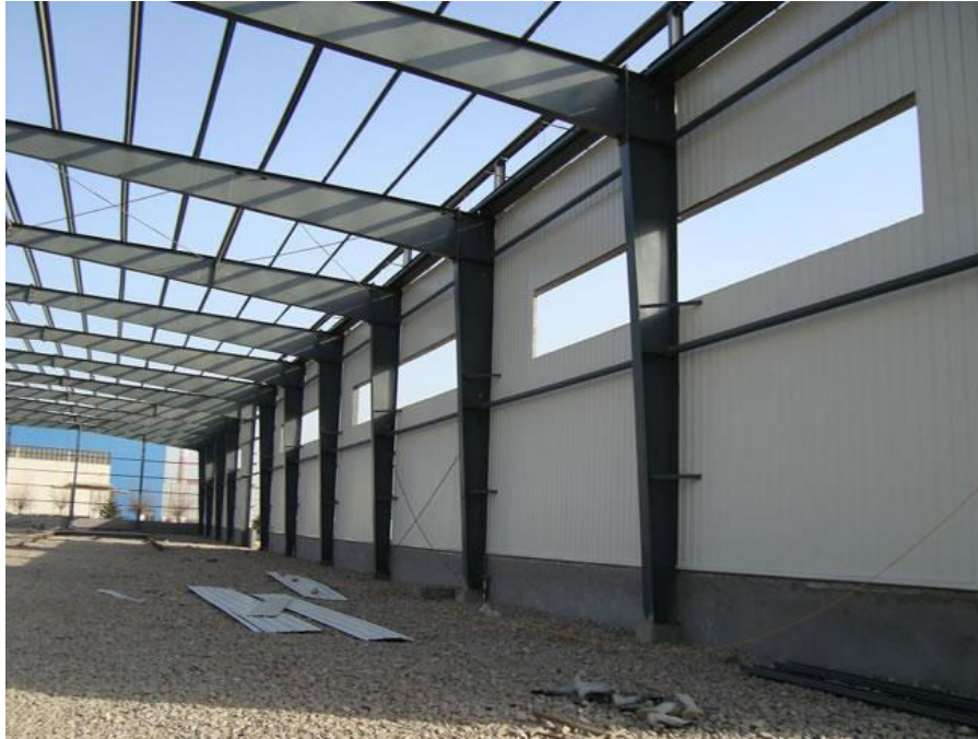
Figura 3.5 Pórtico de acero
