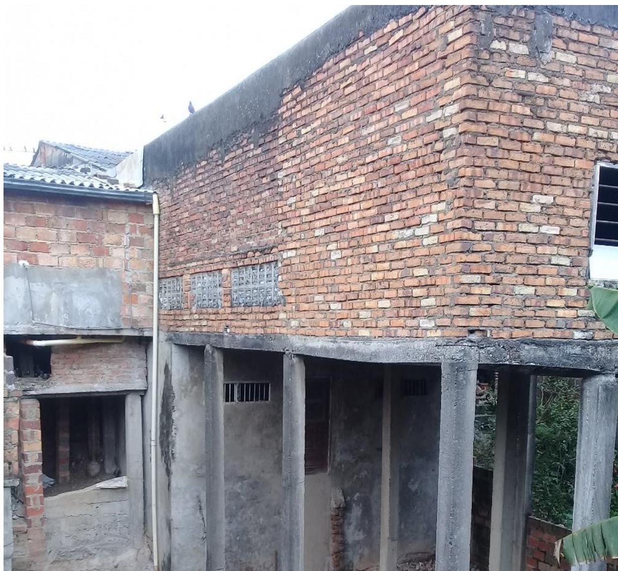
Fotografía 3.4 Mampostería no reforzada apoyada sobre columnas y losa de concreto
