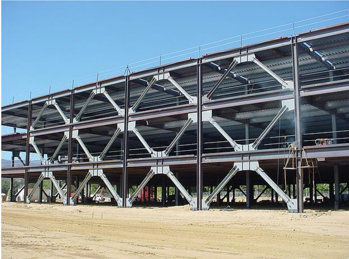
Figura 3.6 Pórtico en acero arrostrado
