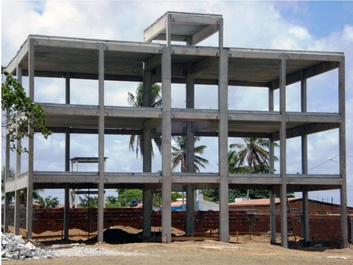
Figura 3.4 Pórtico en concreto
