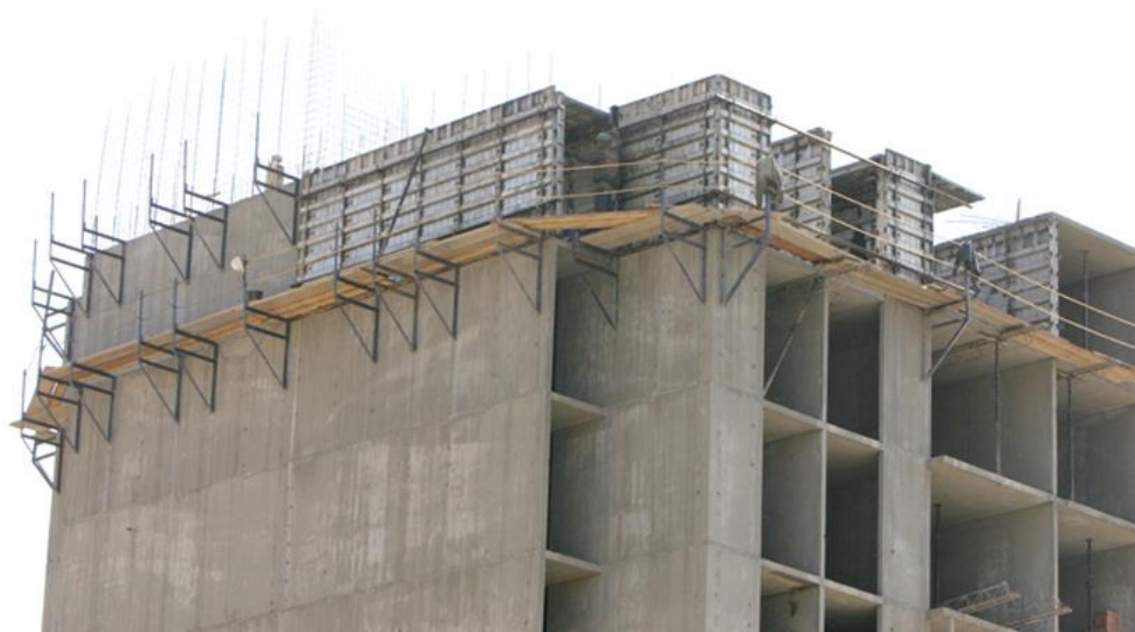
Figura 3.3 Muros vaciados en concreto reforzado
