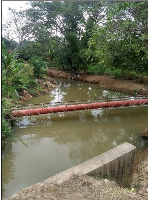
Figura.5. Invasión del cauce Quebrada Pozo 7
