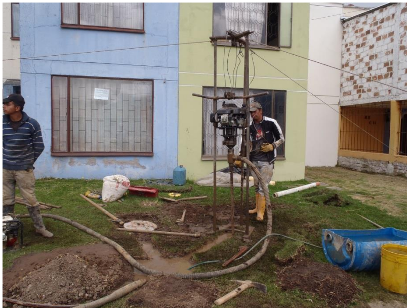
FOTO NO. 13 SONDEO DE VERIFICACION No. 07.
