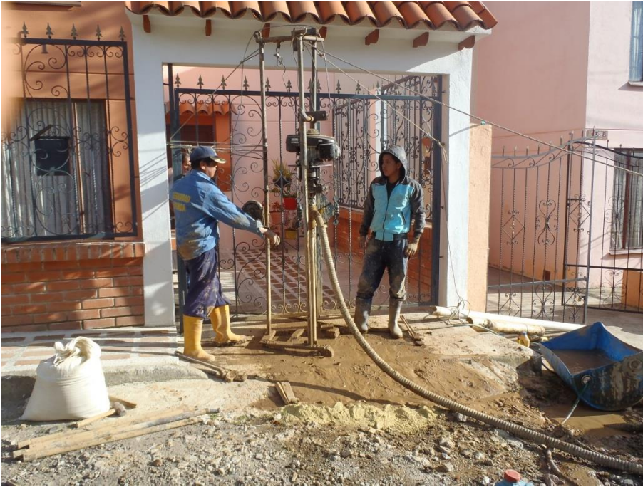
FOTO NO. 14 SONDEO DE VERIFICACION No. 14.
