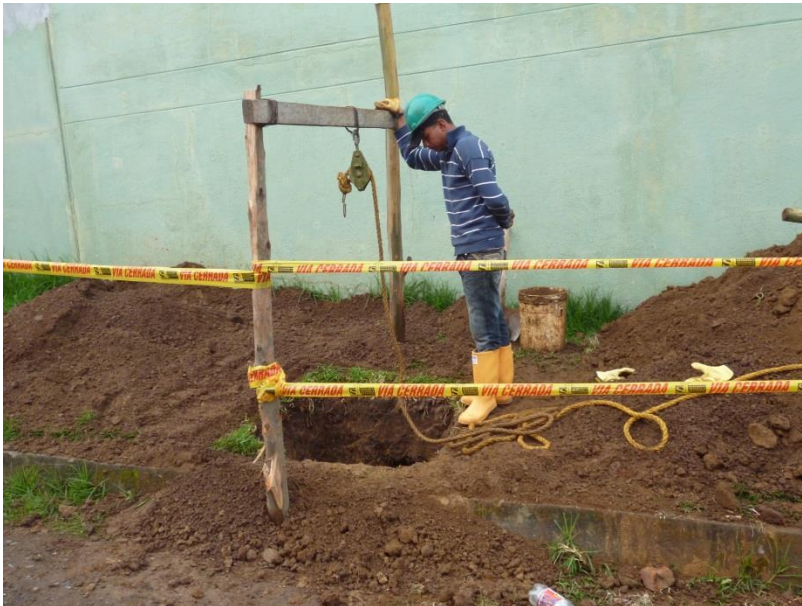
FOTO NO. 19 REALIZACION POZO DE INSPECCION No. 2.
