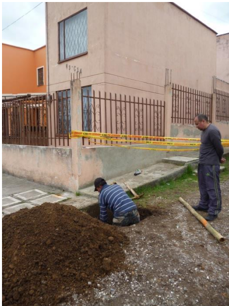
FOTO NO. 21 REALIZACION POZO DE INSPECCION No. 1
