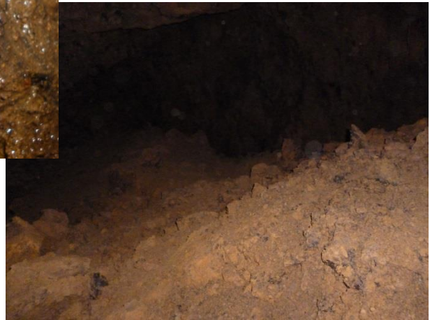
FOTO NO. 20 VISTA DEL SOCAVON No. 3.
