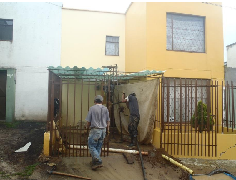
FOTO NO. 15 SONDEO DE VERIFICACION No. 16.
