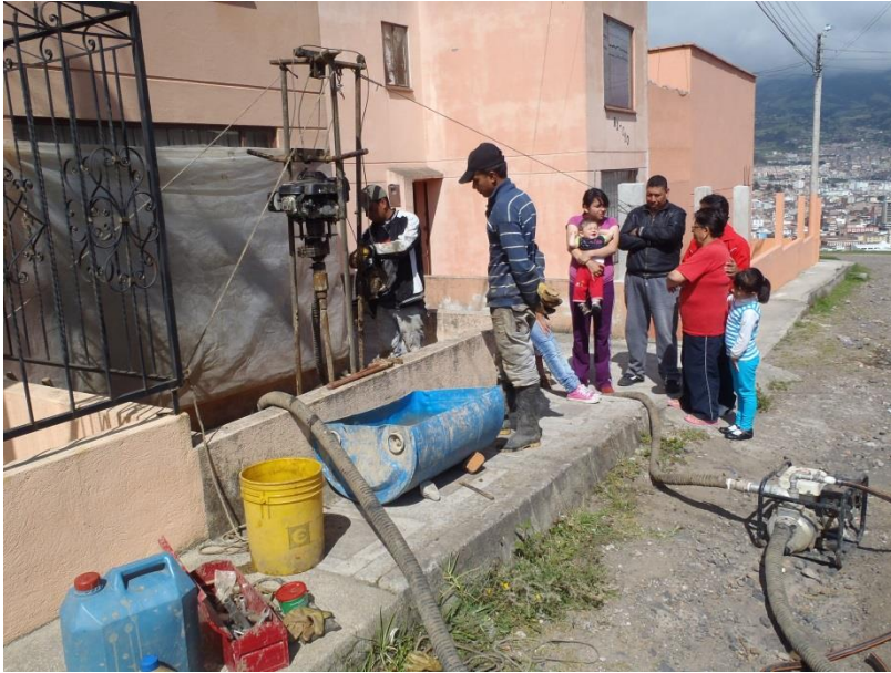
FOTO NO. 12 SONDEO DE VERIFICACION No. 10.
