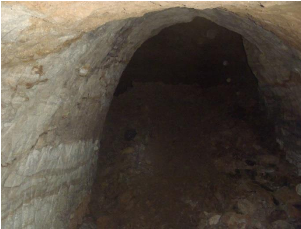
Vista socavón No. 1
