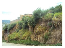
El talud presenta agrietamientos, pendientes inadecuadas, no realizados técnicamente y pendientes negativas, con volúmenes de tierra próximos a derrumbarse, presenta tuberías de alcantarillado al descubierto y la vivienda ubicadas al borde del talud sin ninguna distancia que las aísle de la zona de deslizamiento.
