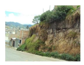
j. Se tiene taludes con agrietamientos muy pronunciados, taludes socavados por corrientes de agua lluvia, algunas se canalizan y otras se descargan sobre el talud, además estos también son erosionados por agua proveniente de lavaderos de ropa, con tuberías de aguas negras al descubierto, esto hace que el talud se vaya erosionando continuamente hasta que se produzca el deslizamiento por la línea de falla, con viviendas construidas con cartones y sostenidas por guaduas, completamente inestables.
