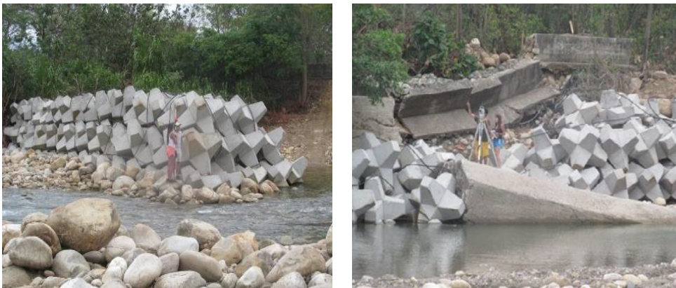
Figura 12. Estructuras hidráulicas para control de socavación en el río Unete. Trabajo de campo de topografía e identificación de estructuras hidráulicas efectuado en el río Unete en enero de 2018 (izq) y (der).
