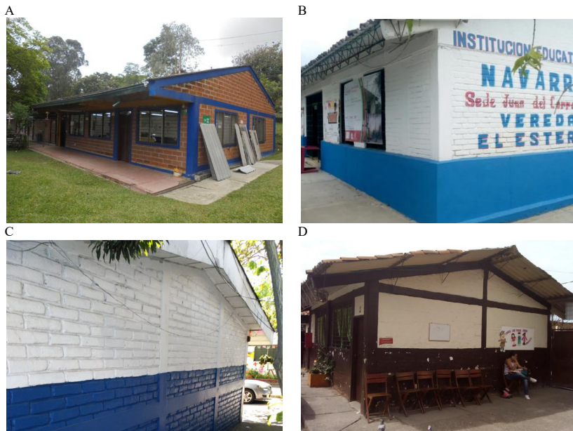
Figura 9. Ejemplos de edificaciones de mampostería confinada. (A) Edificación escolar en Colombia. (B) Edificación escolar en Colombia. (C) Edificación escolar en El Salvador. (D) Edificación escolar en Colombia. Fotos tomadas del GPSS y del archivo personal de los autores.
