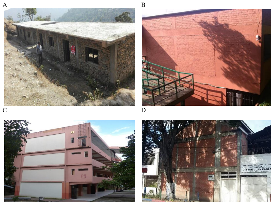
Figura 6. Ejemplos de pórticos de concreto reforzado resistente a momento con muros de mampostería integrados. (A) Edificación escolar en Nepal. (B) Edificación escolar en Colombia. (C) Edificación escolar en Colombia. (D) Edificación escolar en Colombia. Fotos tomadas del GPSS y del archivo personal de los autores.
