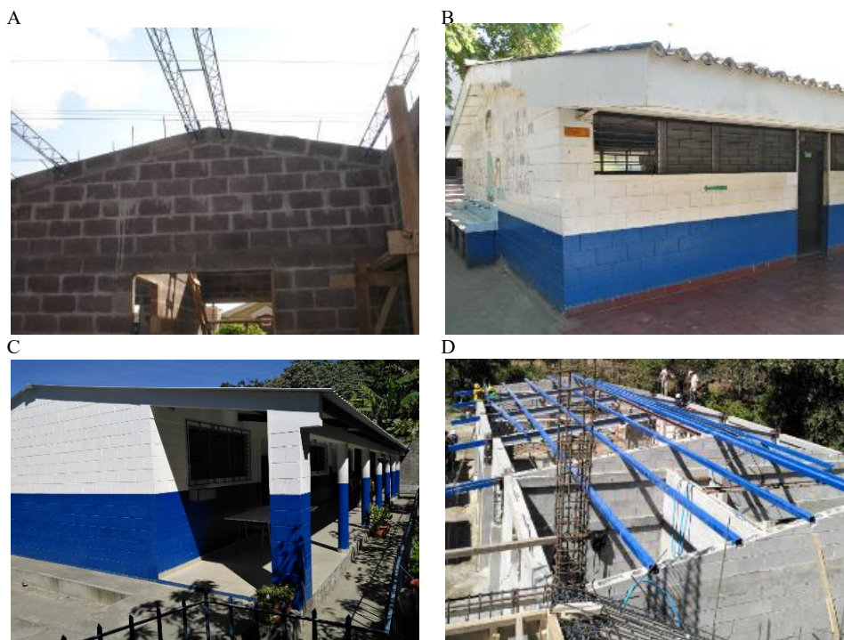
Figura 10. Ejemplos de edificaciones de mampostería reforzada. (A) Edificación escolar en Colombia. (B) Edificación escolar en El Salvador. (C) Edificación escolar en El Salvador. (D) Edificación escolar en construcción en El Salvador. Fotos tomadas del GPSS y del archivo personal de los autores.
