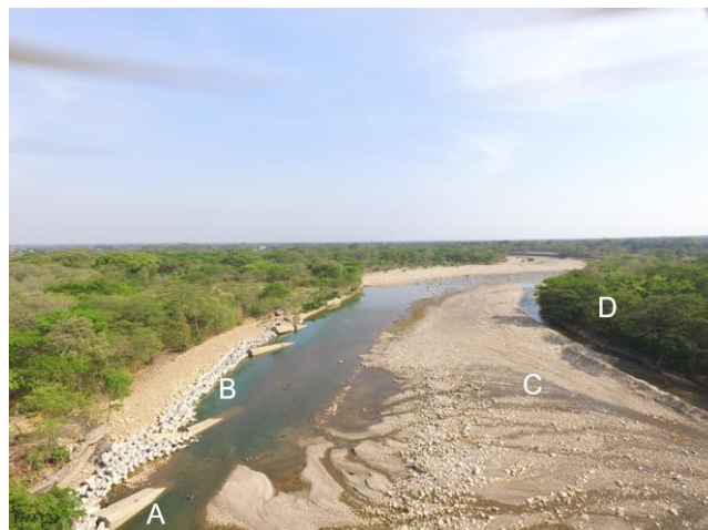
Figura 6. Vista panorámica del río Unete tomada con dron. Trabajo de campo efectuado en el río Unete en enero de 2018. (A) Espolones en concreto, (B) Estructura de contención con hexápodos, (C) Barra de sedimentos y (D) Terraza.
