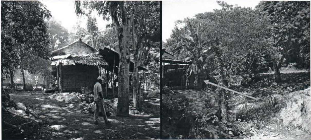
Ilustración 8: Viviendas susceptibles de inundación por la quebrada Palobobo vereda el Carmelito
