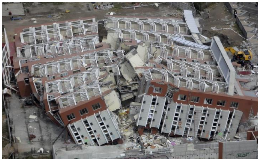
Figura 2. Edificación colapsada en Concepción como consecuencia del sismo. Fuente: (EL PAÍS, 2020)
