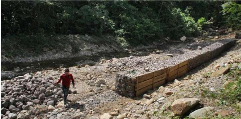
En el caño Buque del barrio Buganviles se ejecutan labores de construcción de un muro en gaviones.
