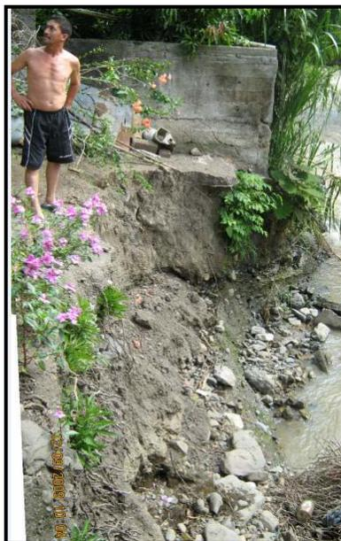
**Figura 3-15. Desprendimientos de tierra y detritos en la margen derecha del Río Uramita en el sector Barrio El Socorro Calle 24**
