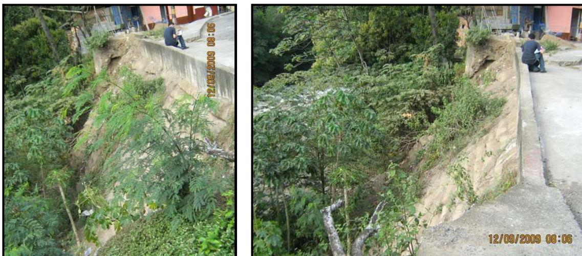
**Figura 3-20. Desprendimientos de tierra y detritos en la margen derecha del Río Sucio en el sector comprendido entre las desembocaduras de la Quebrada Encalichada y el Río Uramita**
