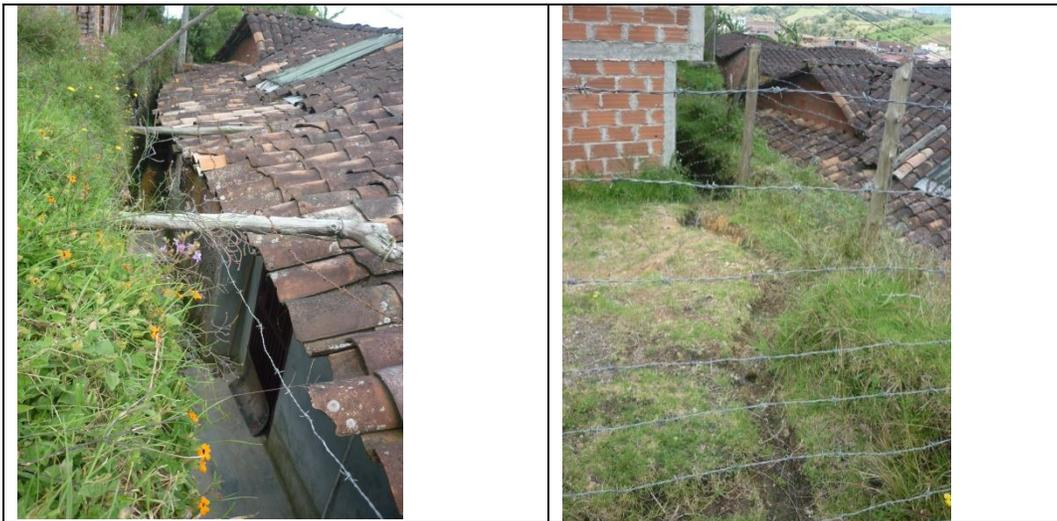
FIGURA 32 FOTOS 5 Y 6: DAÑO EN TERRENO POR AGUAS EN SUPERFICIE Y AMENAZA PARA VIVIENDAS EN LA PARTE BAJA, BARRIO BUENOS AIRES
