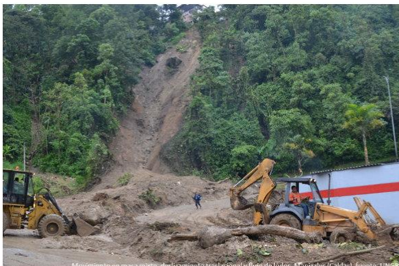
Movimiento en masa mixto: deslizamiento traslacional y flujo de lodos, Manizales (Caldas). Fuente: UNGRD
