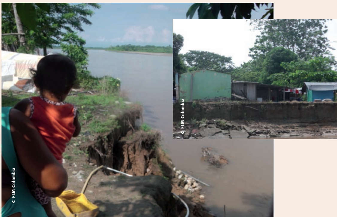
Fotos No. 12 y 13. Desbarrancamientos en Puerto Lleras.
