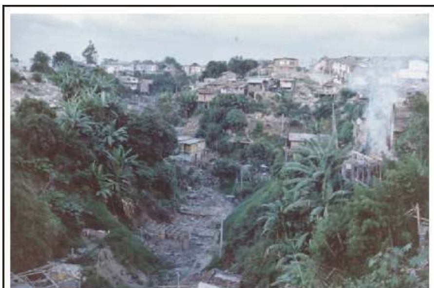
Deslizamiento Barrio Santander Armenia, Quindío, Colombia
