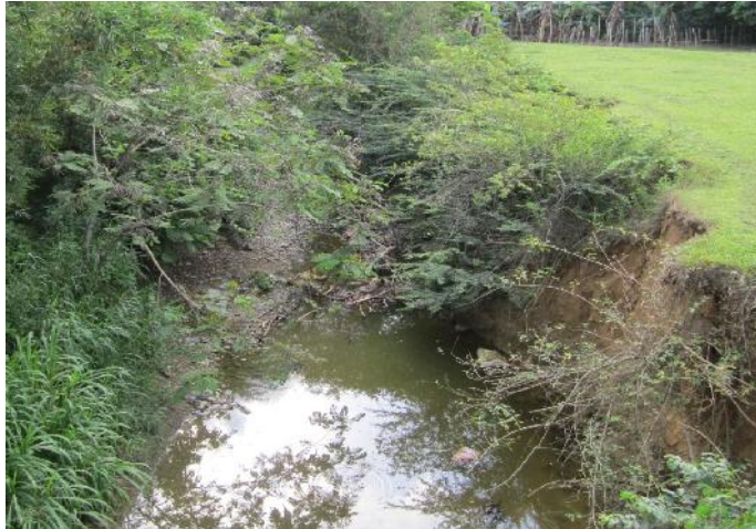
FOTOGRAFÍA 5. PROCESOS INCIPIENTES EN LA MARGEN IZQUIERDA DE LA QUEBRADA EL PIRÚ, COMIENZO DE LA PÉRDIDA DE MATERIAL Y VEGETACIÓN.
