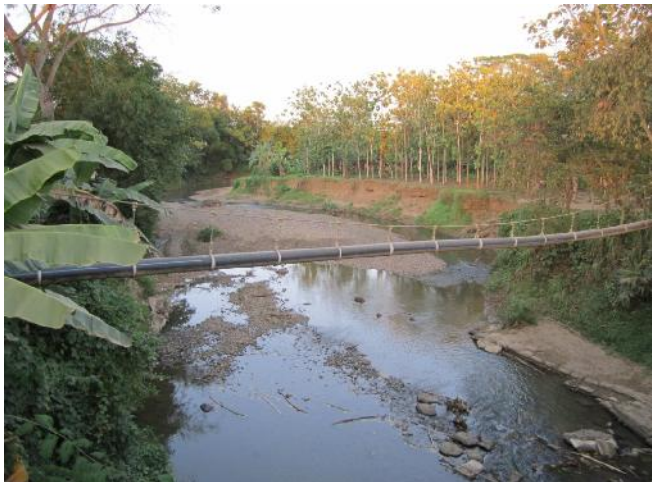
FOTOGRAFÍA 2-1 PROCESO ACTIVO EN LA MARGEN DERECHA DEL RÍO SAN JUAN, PÉRDIDA DE MATERIAL EVIDENTE.
