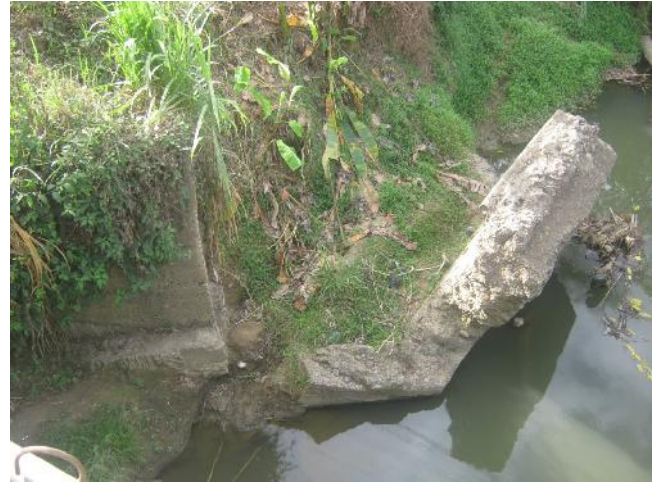
FOTOGRAFÍA 7-1 SOCAVACIÓN LATERAL EN CERCANÍAS A PUENTES. SE HAN REALIZADO ALGUNAS OBRAS DE CONTENCIÓN Y MITIGACIÓN COMO GAVIONES.
