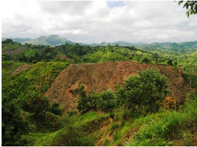
Fotografía 24 Vereda Tacanal abajo: Deslizamiento
