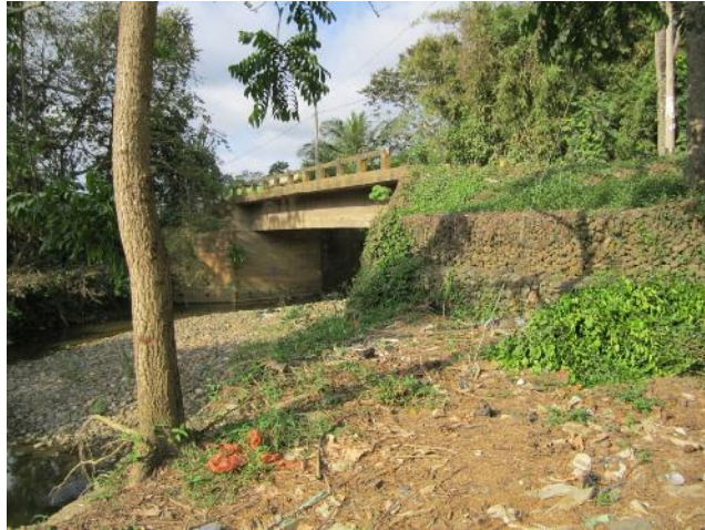
FOTOGRAFÍA 7-1 SOCAVACIÓN LATERAL EN CERCANÍAS A PUENTES. SE HAN REALIZADO ALGUNAS OBRAS DE CONTENCIÓN Y MITIGACIÓN COMO GAVIONES.
