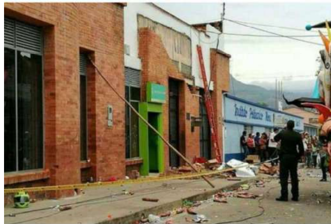
Los ladrillos cayeron sobre varias personas que estaban en el andén, observando el paso de las carrozas que hacían parte del Carnaval del Oriente. (Foto: Suministrada /WANGUARDIA LIBERAL)
