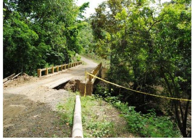
Fotografía 17 Puente Tacanal abajo: Socavación lateral margen. izquierda de la quebrada
