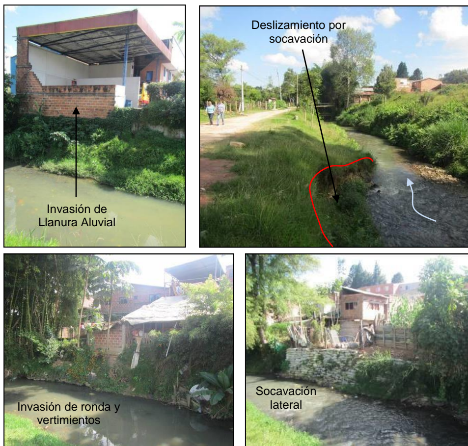
Figura . Invasión de la llanura y socavación lateral en el barrio San Antonio
