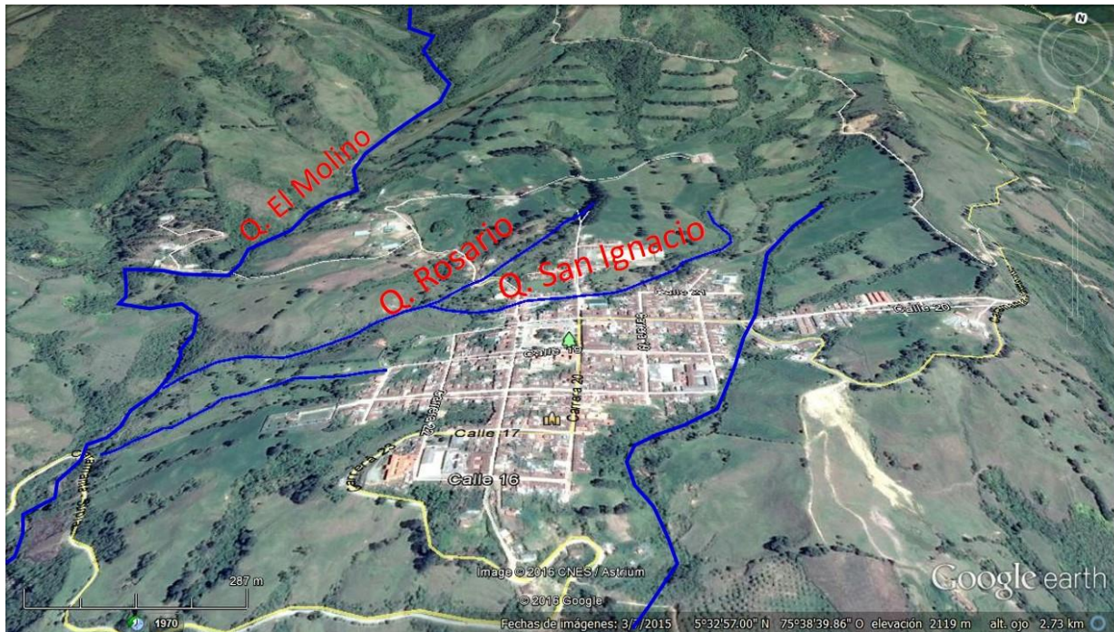
Foto 1. Quebradas que atraviesan el casco urbano en el Municipio.
